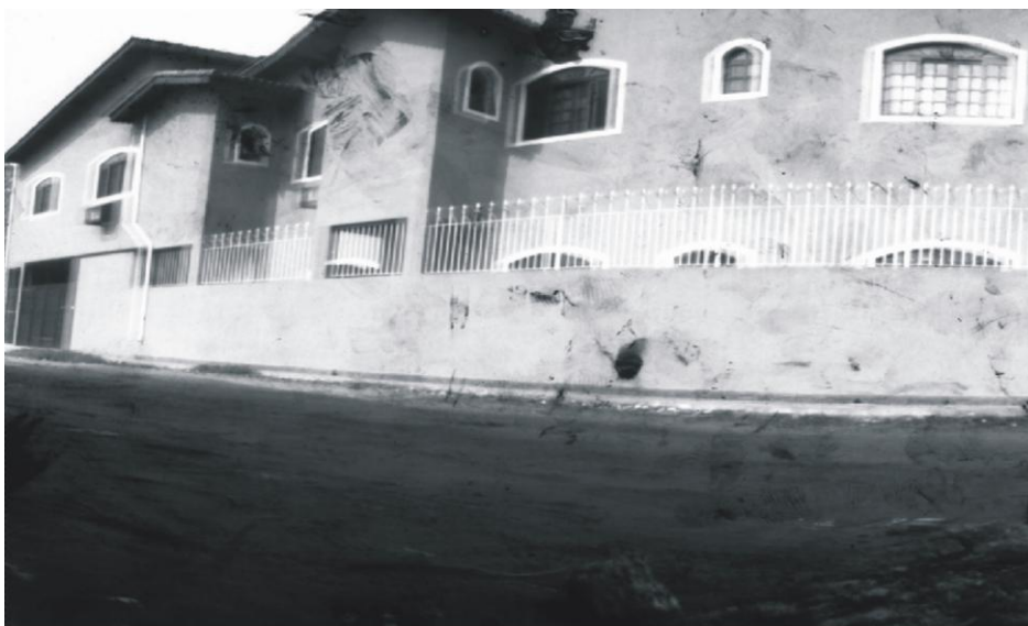
Figura 47. Janelas e celas
