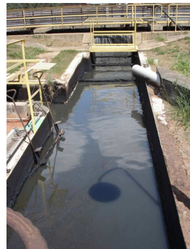
Figura 9. Ponto 6 – entrada do efluente bruto (industrial e doméstico) na estação de tratamento biológico.
