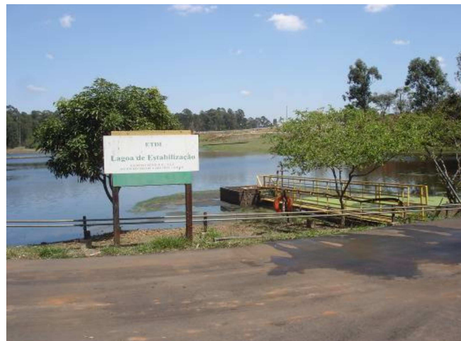
Figura 5. Ponto 3 – Saída do efluente tratado e estabilizado para o Rio Atibaia.
