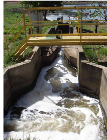
Figura 4. Ponto 2 - entrada do efluente industrial tratado biologicamente na lagoa de estabilização.
