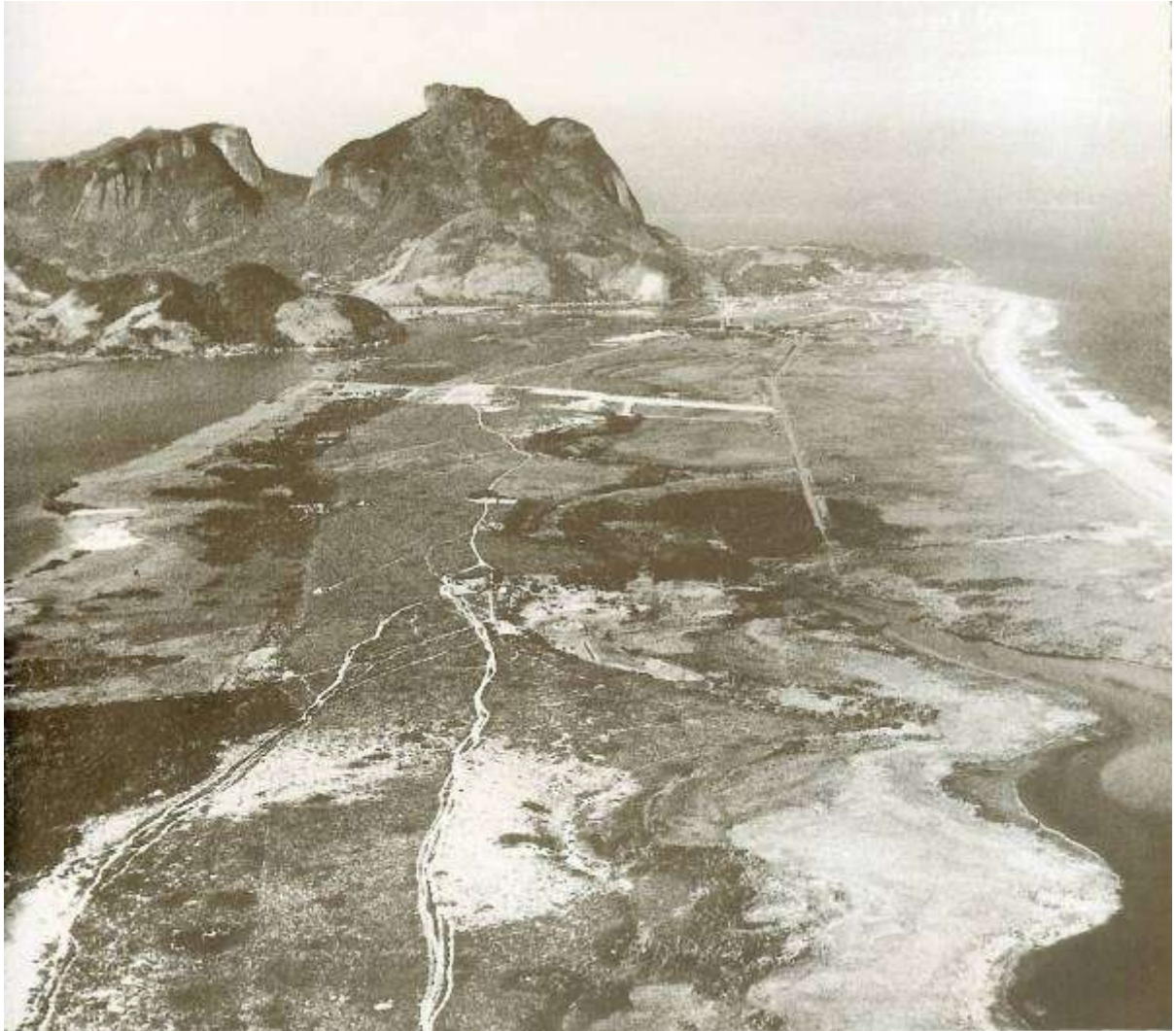
Figura 13 - Barra da Tijuca entre as décadas de 1950 a 1960
