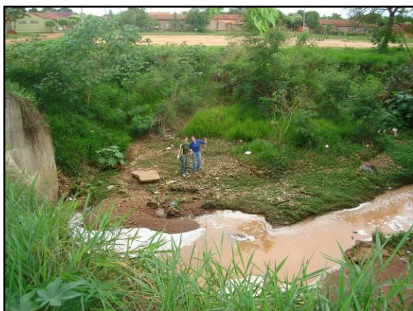
Figura 9.: Início do canal exposto; saída dos dutos de escoamento da zona urbana (2009).
