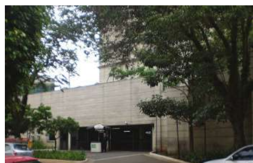
Figura 127 - Rua Tito - Acesso à garagem e portaria de serviços. Segurança pessoal para controle da segurança. Fonte: SAMPAIO, 20/ set/2009.
