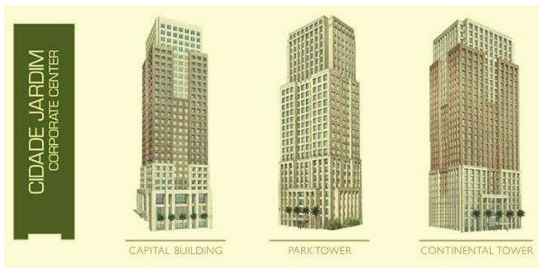
Figura 69 - Fachada dos prédios comerciais
