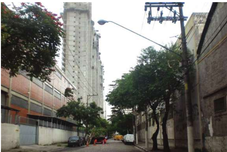
Figura 107 - Prédios em construção na rua Hassib Mofarrej.
