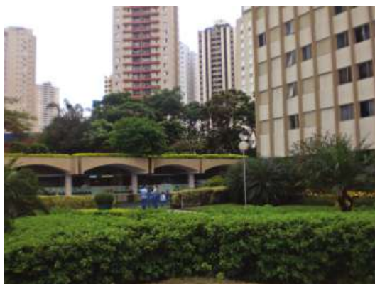
Figura 33 - Vista da escola infantil
