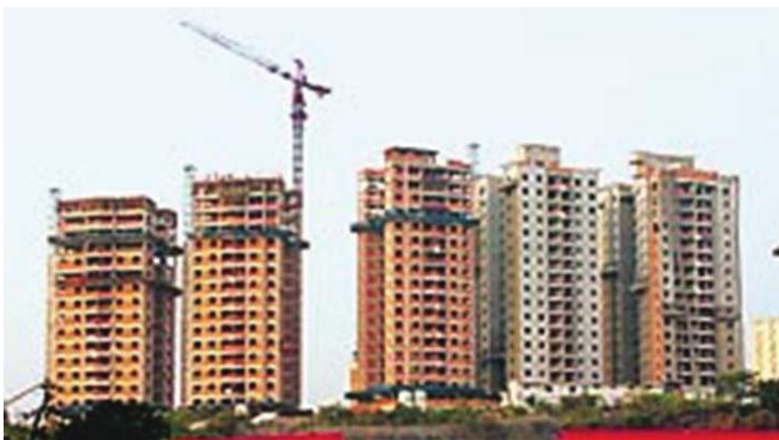
Figura 102 - Conjunto residencial em obras na Avenida General Mac Arthur
