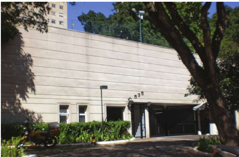
Figura 126 - Rua Tito - Acesso à garagem e portaria de serviços Fonte: SAMPAIO, 20/ set/2009.
