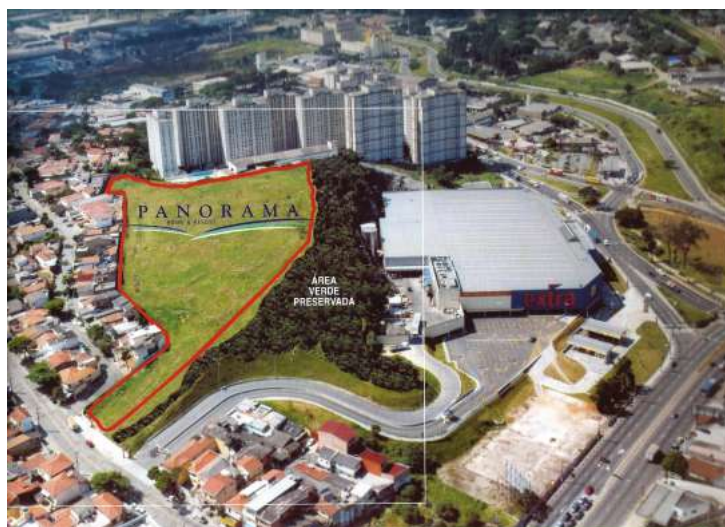
Figura 193 - Vista aérea com destaque para o terreno do condomínio
