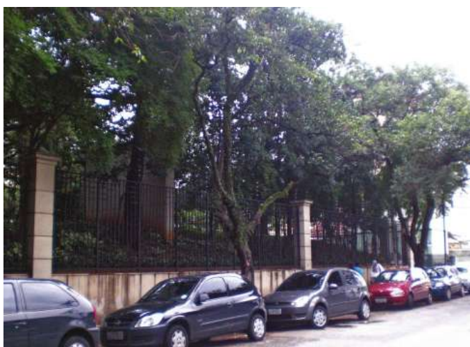
Figura 135 - Rua Tito, muros e gradis do condomínio
