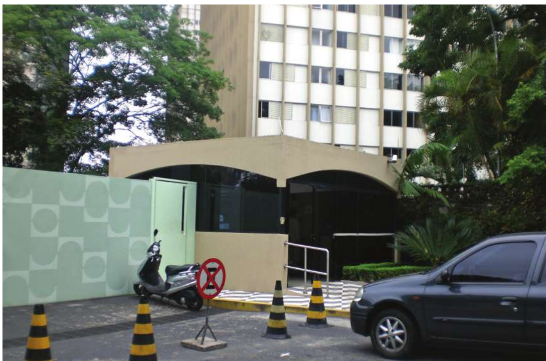
Figura 59 - Condomínio residencial Ilhas do Sul , portaria de serviços (vista da Rua Diógenes Ribeiro de Lima).
