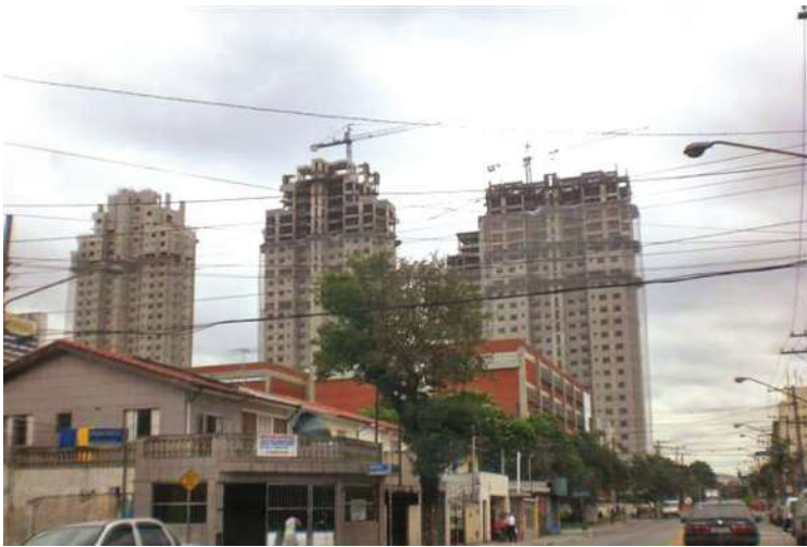
Figura 105 - Av Imperatriz Leopoldina, ao fundo prédios em construção na rua Hassib Mofarrej
