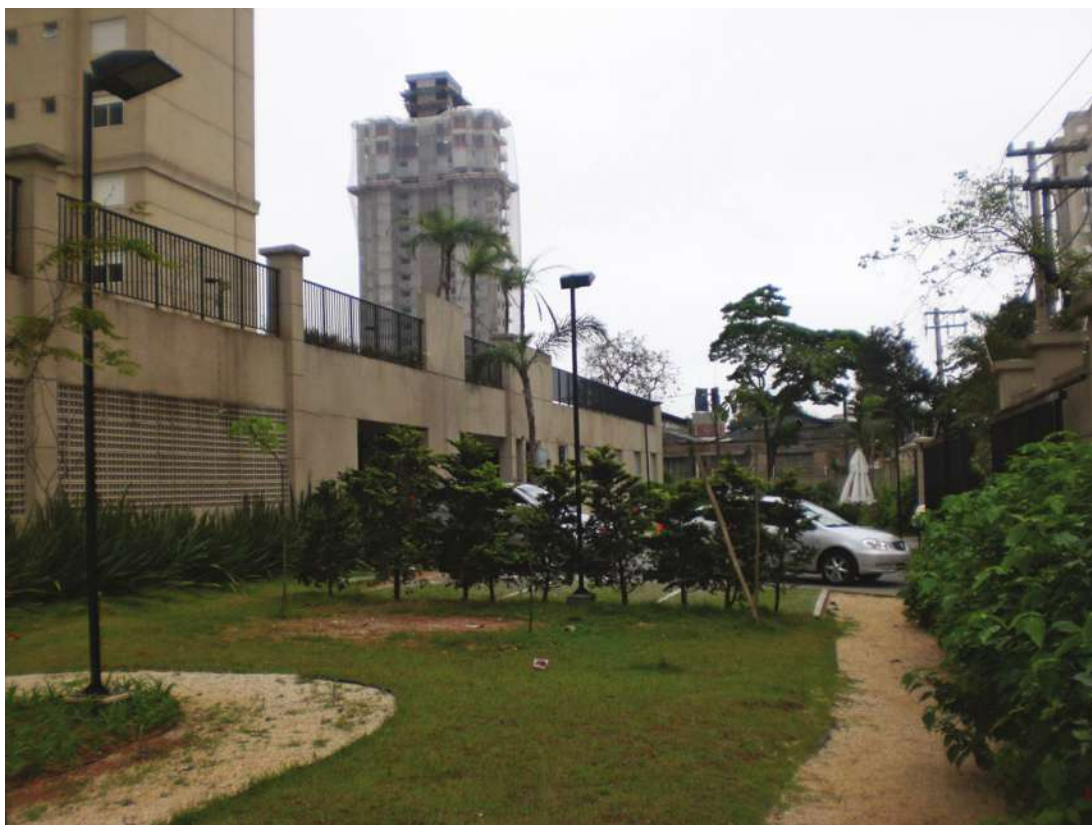
Figura 158 - Praça e acesso à garagem, em desnível.
