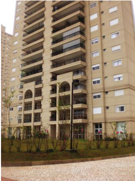
Figura 161 - Vista do edifício
