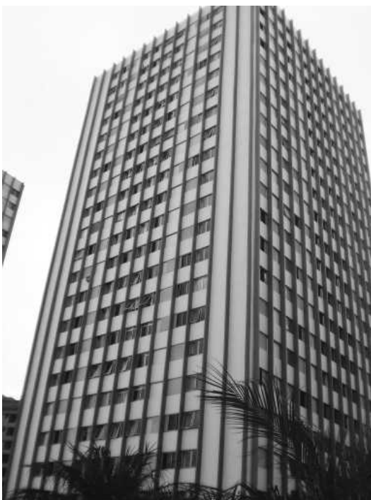
Figura 40 - Fachada de um dos seis prédios Fonte: SAMPAIO, 10/out/2009.
