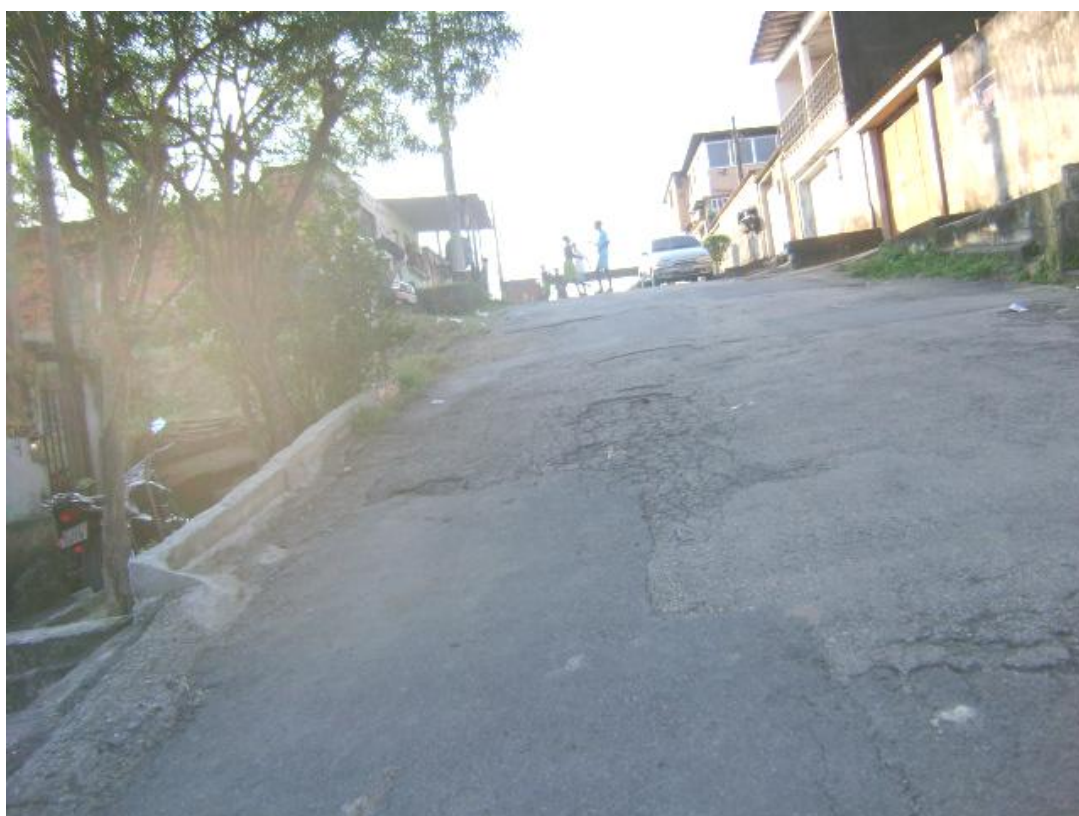
Fotografia 48- Rua José Cabral como Zona de Fronteira. Créditos: Vitória.
