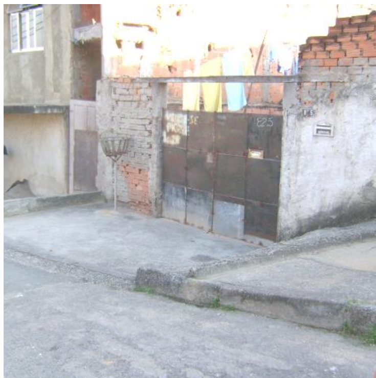
Fotografia 49- Rua José Cabral como Zona de Fronteira. Créditos: Vitória.
