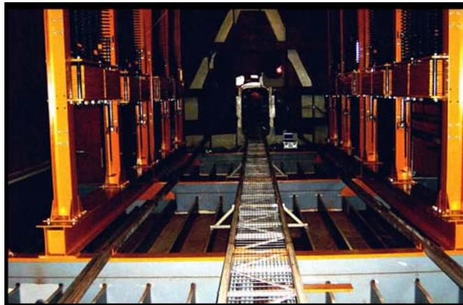
Fig. 1.2 – Detalhe com oito absorvedores instalados no vão central da Ponte Rio – Niterói [42].
