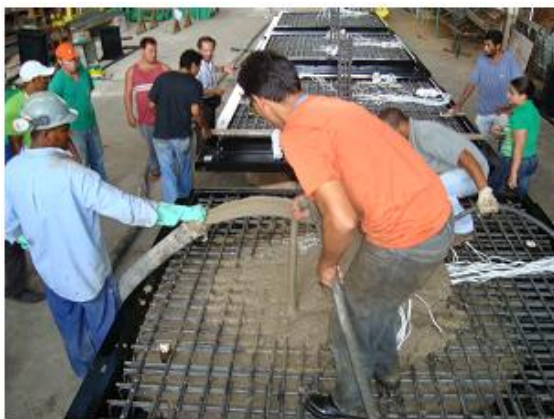
(a) Utilização da bomba e vibradores.
