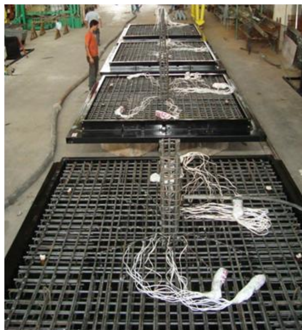
Figura 3.19 – Aspecto final das fôrmas com as armaduras de flexão dos modelos.
