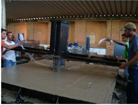
(c) Colocação da fôrma do pilar.
