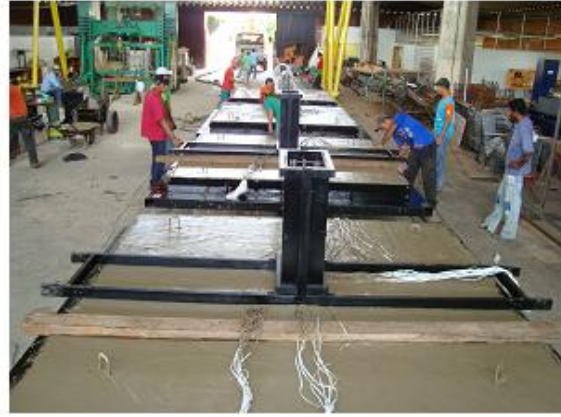
(d) Acabamento na superfície da laje.
