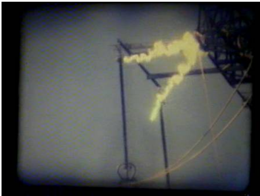
Figura 3.4: Arco Secundário iniciado curto circuitando o isolador de Linha
