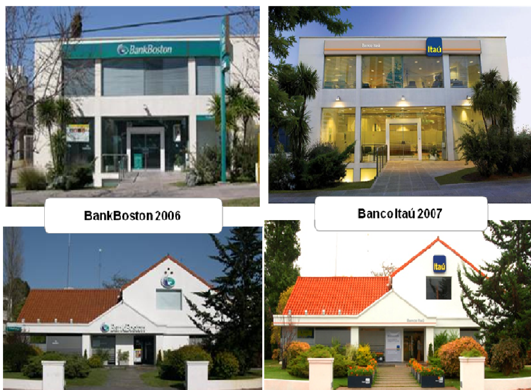
Figura 20 – Fachada das agências do BankBoston antes da compra pelo Itaú e depois
