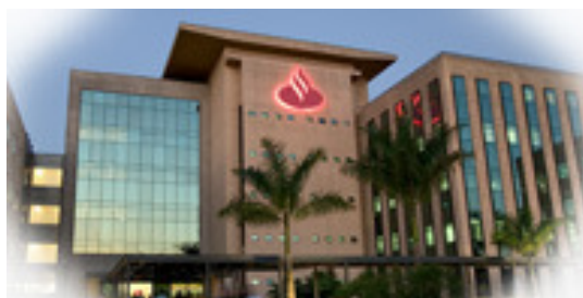
Figura 34 – Prédio do Banco Santander FONTE: http://www.santander.com.br
