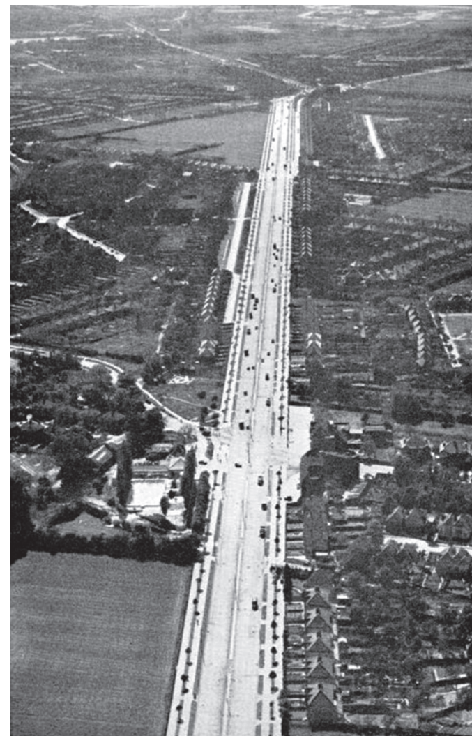
Figura 25: Aspectos da urbanização linear ao longo das vias rurais (Ribbon Development) - Great West Road, RU, 1951 Fonte: HALL, 2002: 24
