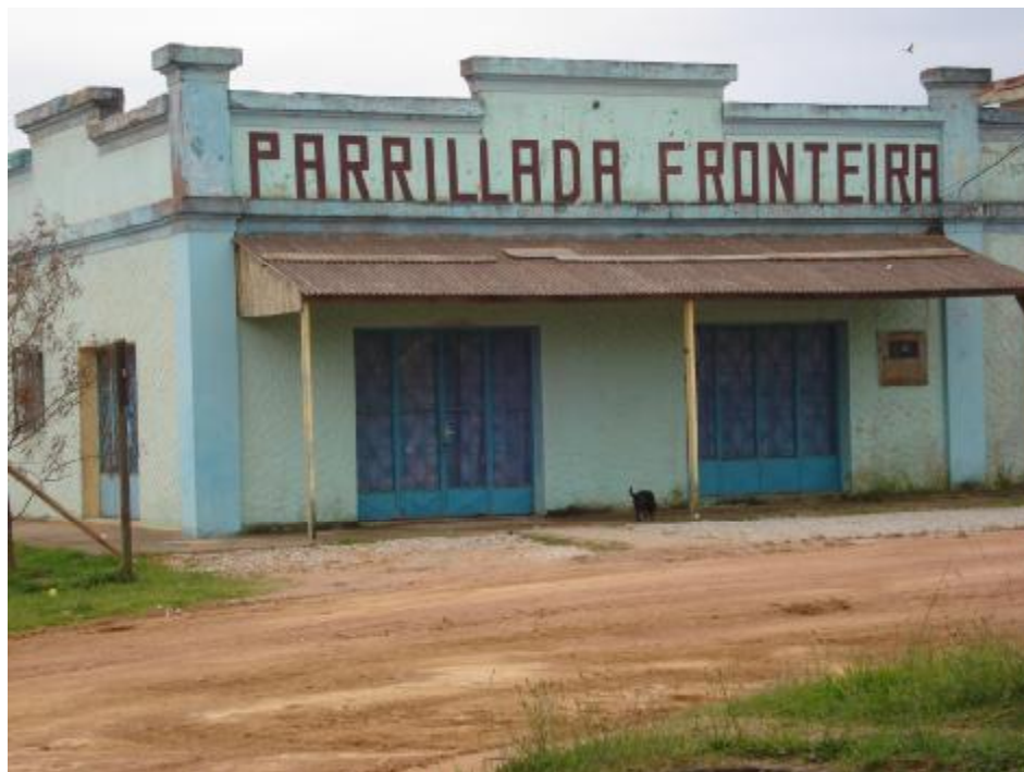
Figura 20 – Ex-supermercado, que depois abrigou um restaurante, fechado há pouco, Aceguá (RS) .
