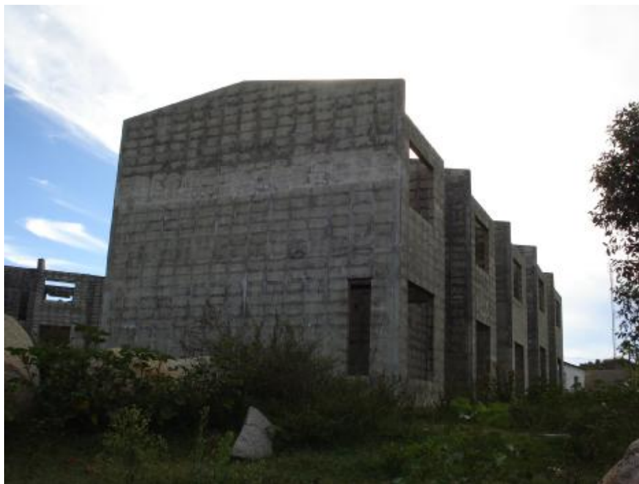
Figura 26 – Obra paralisada de um conjunto habitacional uruguaio, em Acegua, Departamento de Cerro Largo, Uruguai.
