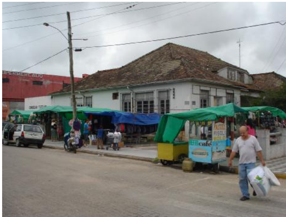
Figura 10 – Prédio da antiga Escola Estadual de Ensino Médio Marechal Soares de Andréia, na esquina da Rua Colômbia com a avenida internacional, em Chuí (RS), onde os artesãos expõem, eventualmente, seus produtos.
