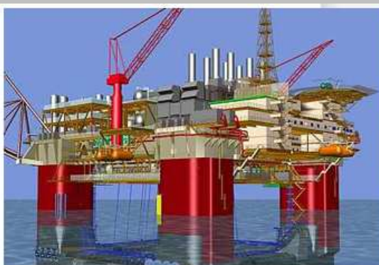
Plataforma Semi-submersível (P-52)
