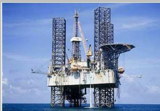
Plataforma Auto-elevatória (PA-6)
