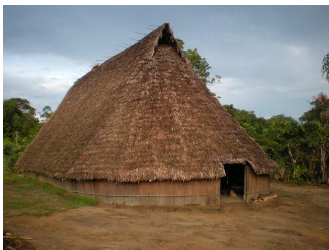
Maloca arredondada en la parte trasera
