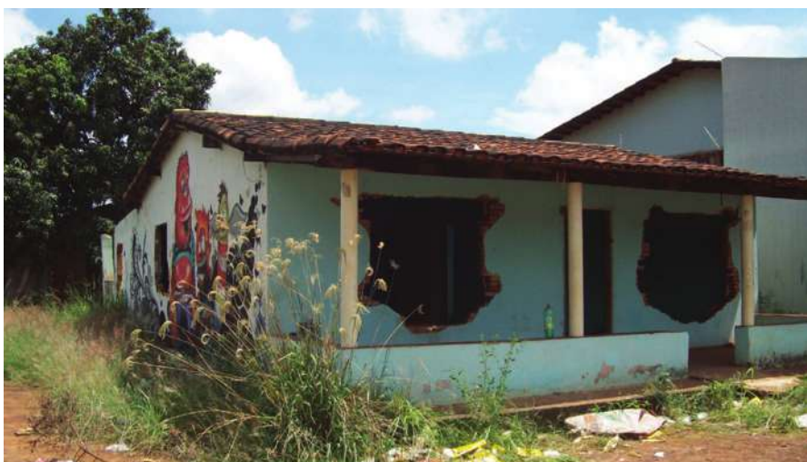
Imagem 64- Avenida Rio Negro, esquina com Rua Tauá, Parque Amazonas, Goiânia-GO. Autoria da foto: Rubens Pereira Salomão, 25 fev. 2009.
