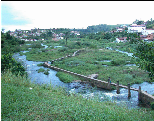
FOTOGRAFIA 8 – Passarela em pedra e madeira sobre o Rio Jiquiriçá, ligando o Centro ao Bairro Santo Antonio, na cidade de Mutuípe (até 2005). Fonte: Prefeitura Municipal de Mutuípe/COOP. Pesquisa de campo 2010.
