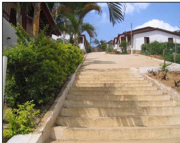
FOTOGRAFIA 7 - Rua do Loteamento Dom Vital pavimentada via OP. Fonte: Prefeitura Municipal de Mutuípe/COOP. Pesquisa de campo 2008.
