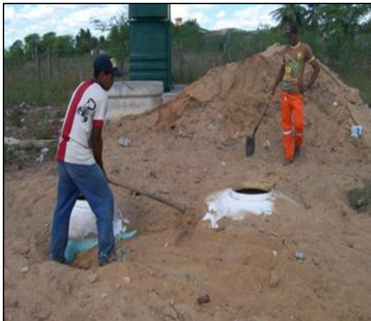
Figura 19A: Instalação do filtro anaeróbio e decanto digestor.
