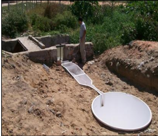
Figura 11A: Vista lateral do tanque.
