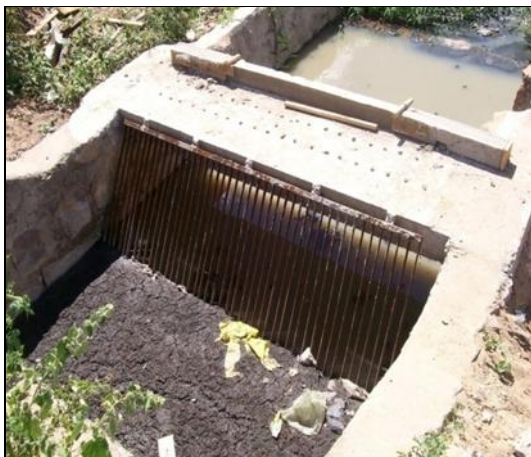
Figura 7A: Gradeamento para retenção de sólidos grosseiros.
