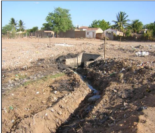
Figura 5A: Vista do ETE em construção.
