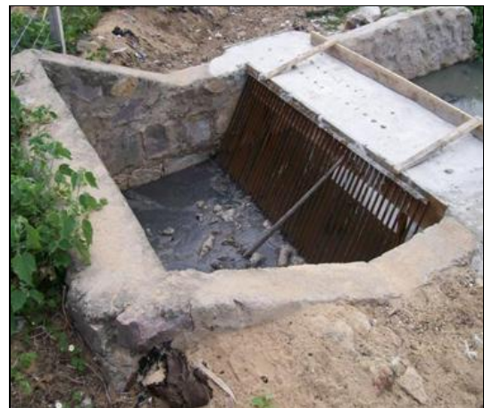
Figura 8A: Vista Lateral do Gradeamento.
