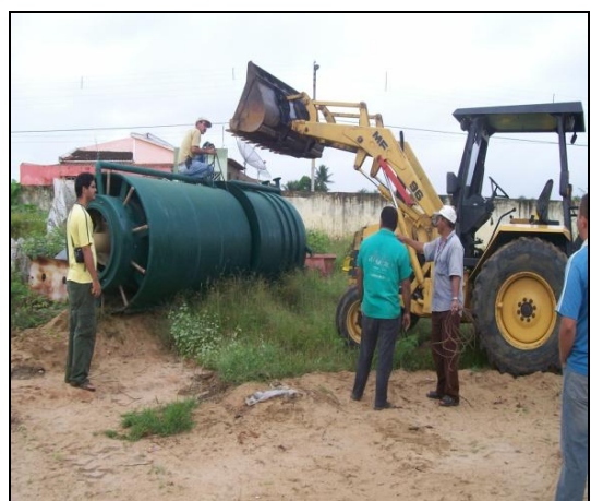
Figura 16A: Instalação do UASB.
