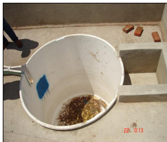
Figura 10A: Instalação do tanque de mistura.
