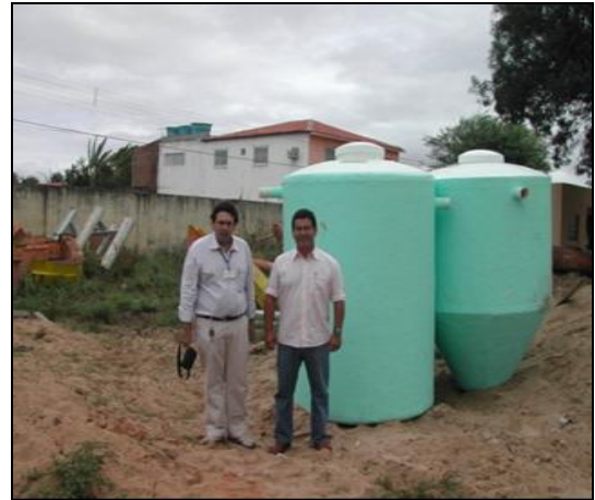
Figura 18A: Filtro Anaeróbio e decanto digestor
