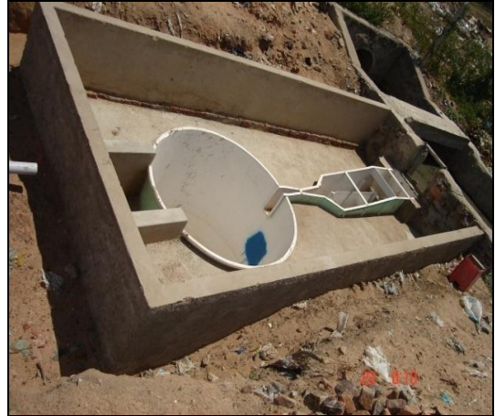
Figura 12A: Acabamento do tanque.
