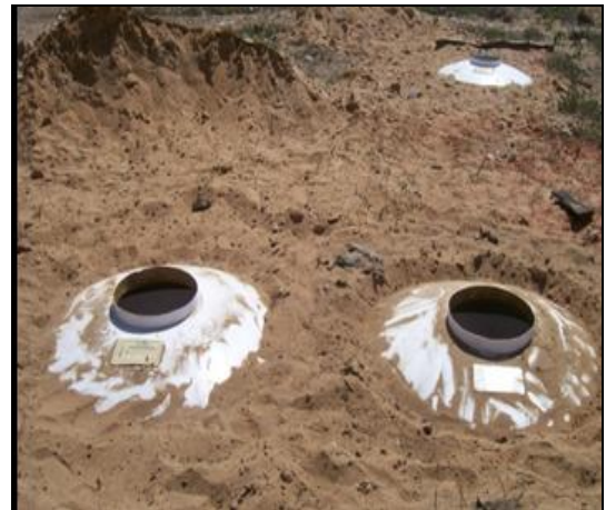
Figura 20A: Filtro e decanto já instalados.
