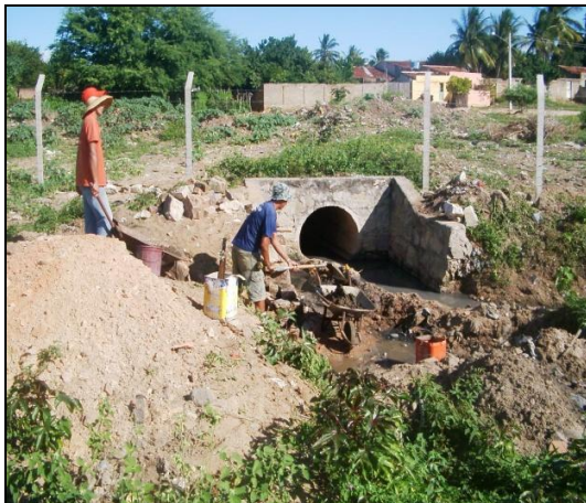
Figura 3A: ETE em construção.
