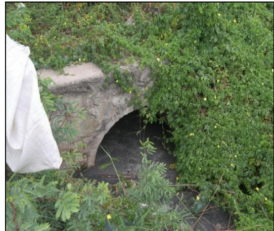
Figura 2A: Vista da saída do esgoto.
