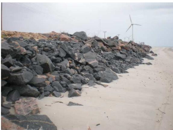
**Foto 5.14:** Intervenção tipo *Hard* para tentar evitar a erosão sedimentar da costa e preservar a estrada de acesso ao campo Serra de produção de petróleo e gás, como também de energia eólica. Foto: Bruno Costa. (2010).
