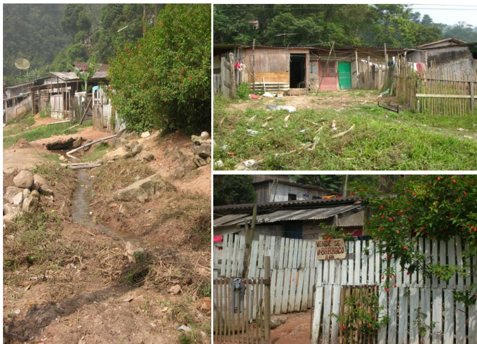
Fotos: Visita técnica realizada em 17/04/2007
