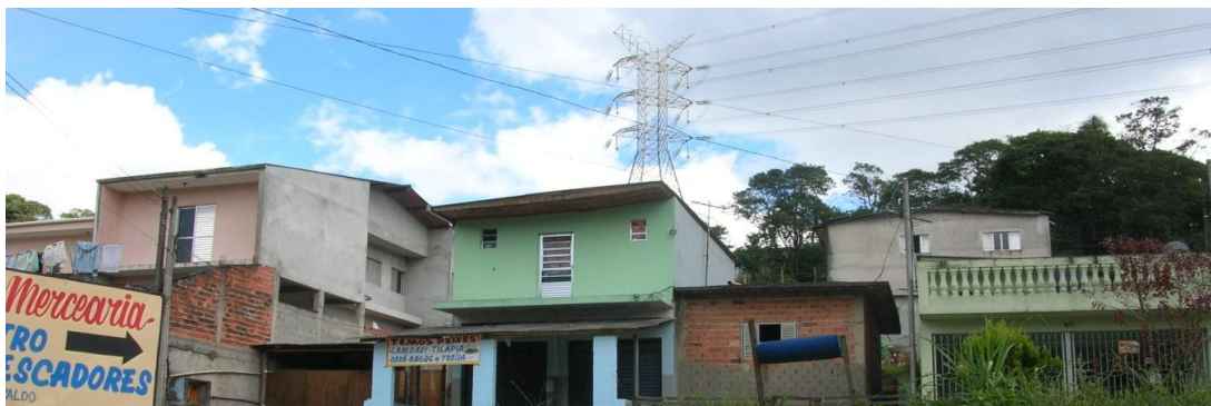
Fotos: Visita técnica realizada em 17/04/2007
