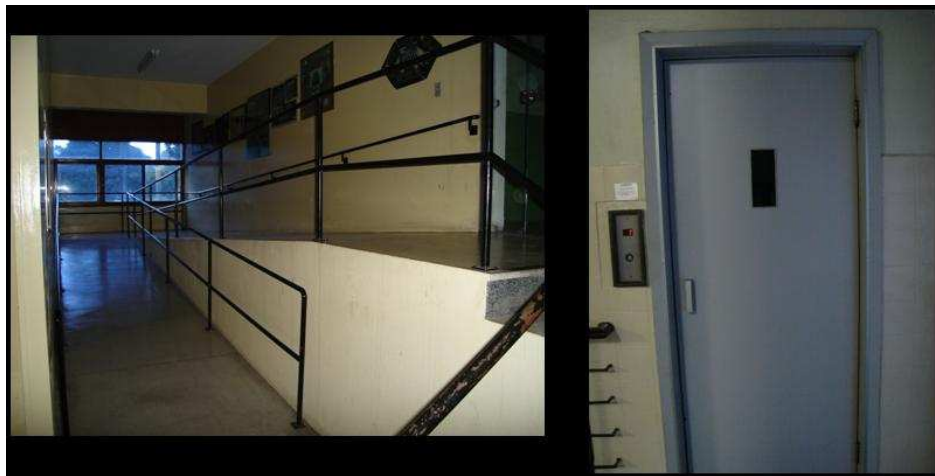
Figura 14 (4): Rampas de acesso e elevador
