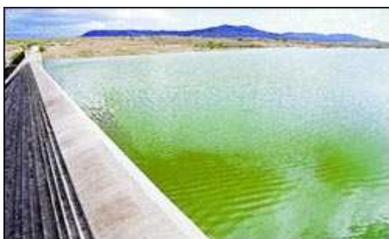
Barragem do Ipojuca
