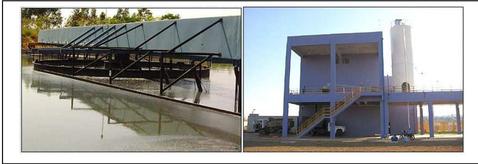
Figura 15 – ETE Goiânia: braços raspadores e unidade de tratamento do lodo
