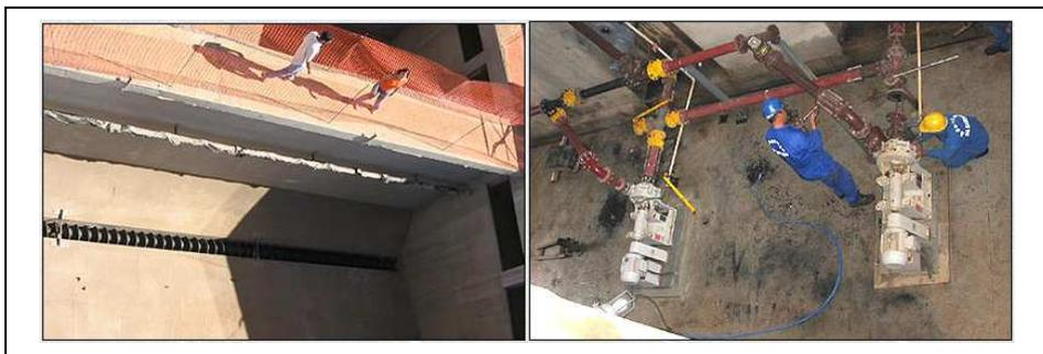
Figura 12 – ETE Goiânia: caixa de areia aerada/recalque
