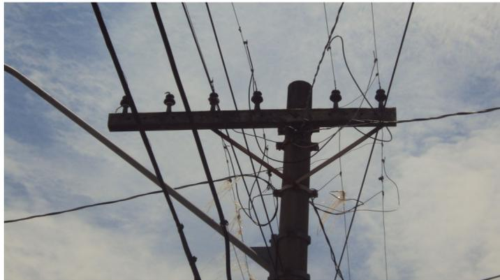
**Figura 1** – Poste de concreto armado com cruzeta de madeira sustentando seis isoladores cerâmicos tipo castanha.
