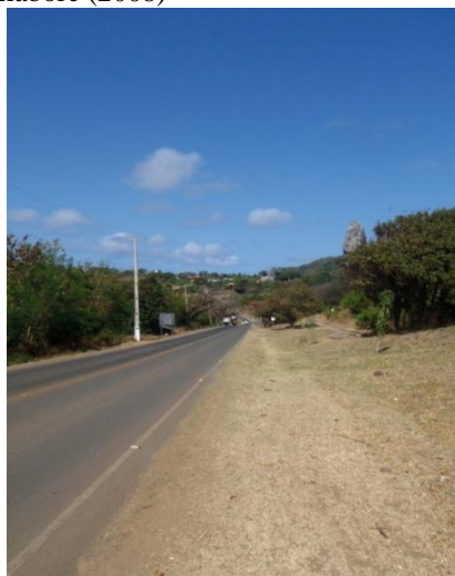
Imagem 37: BR 363 – ausência de acostamento adequado; Fonte: Dados da pesquisa.
