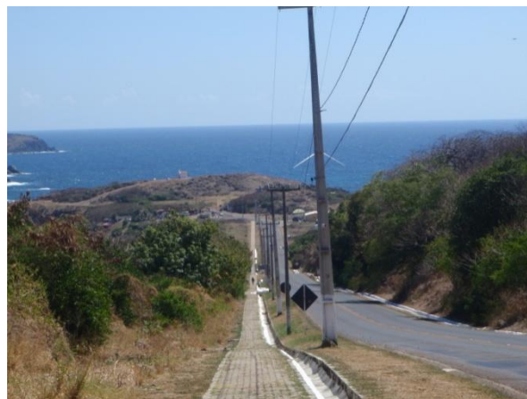
Imagem 38: BR 363 – Ausência de acostamento e Inclinação da rampa fora do recomendado; Fonte: Dados da pesquisa.
