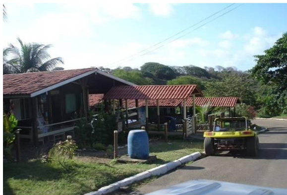
Imagem 31: Construções em madeira; Fonte: Elabore (2008).
