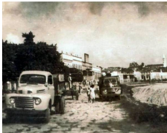
Figura 3 – Construção do cais em Propriá II Fonte: Acervo de domínio público
