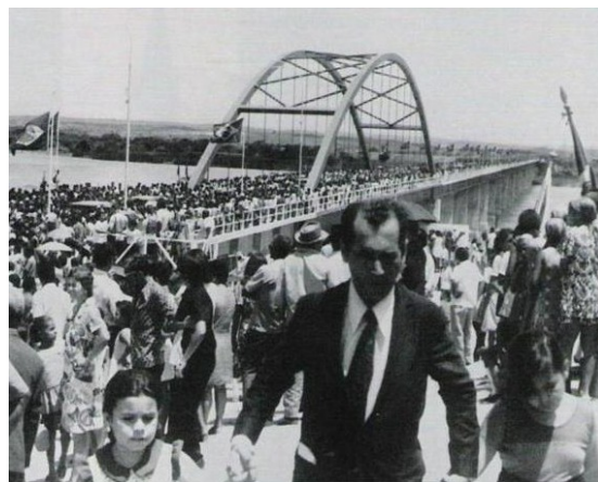
Figura 43 – Inauguração da Ponte II Fonte: Acervo de domínio público
