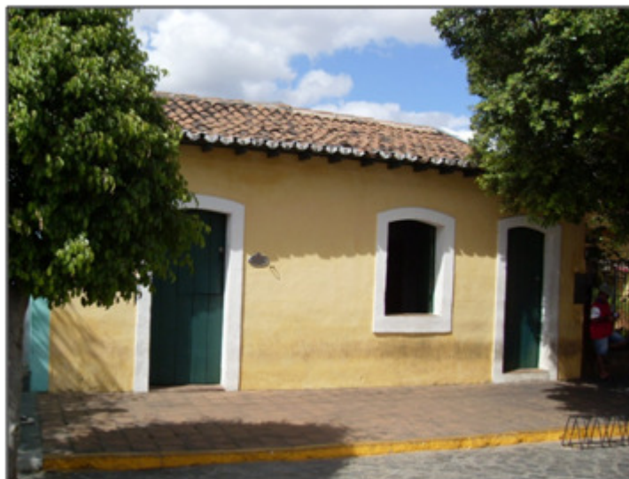
Figura 11. Casa do Capitão-Mor (PMS, 2009).
