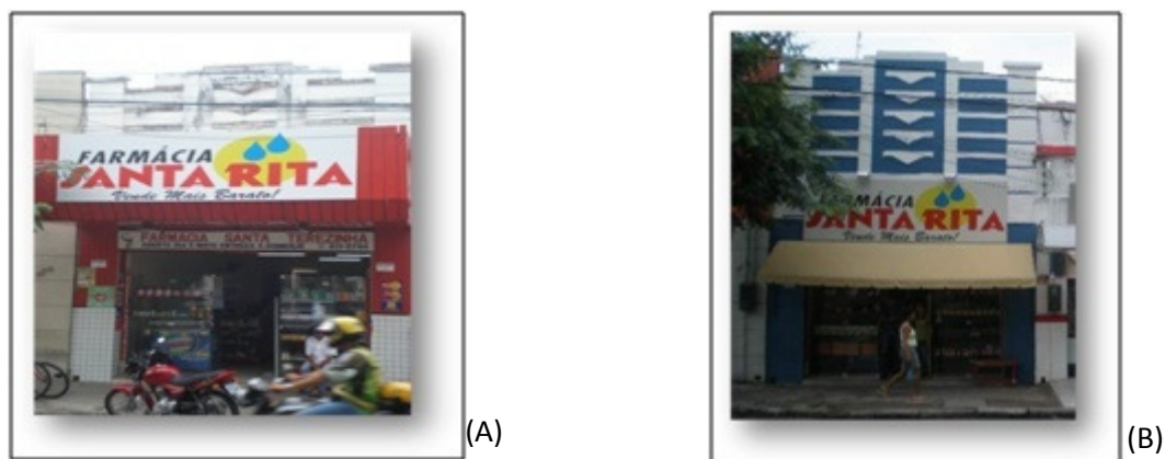
Figura 51. Imóvel 1 com fachada remodelada no centro histórico de Sobral –
