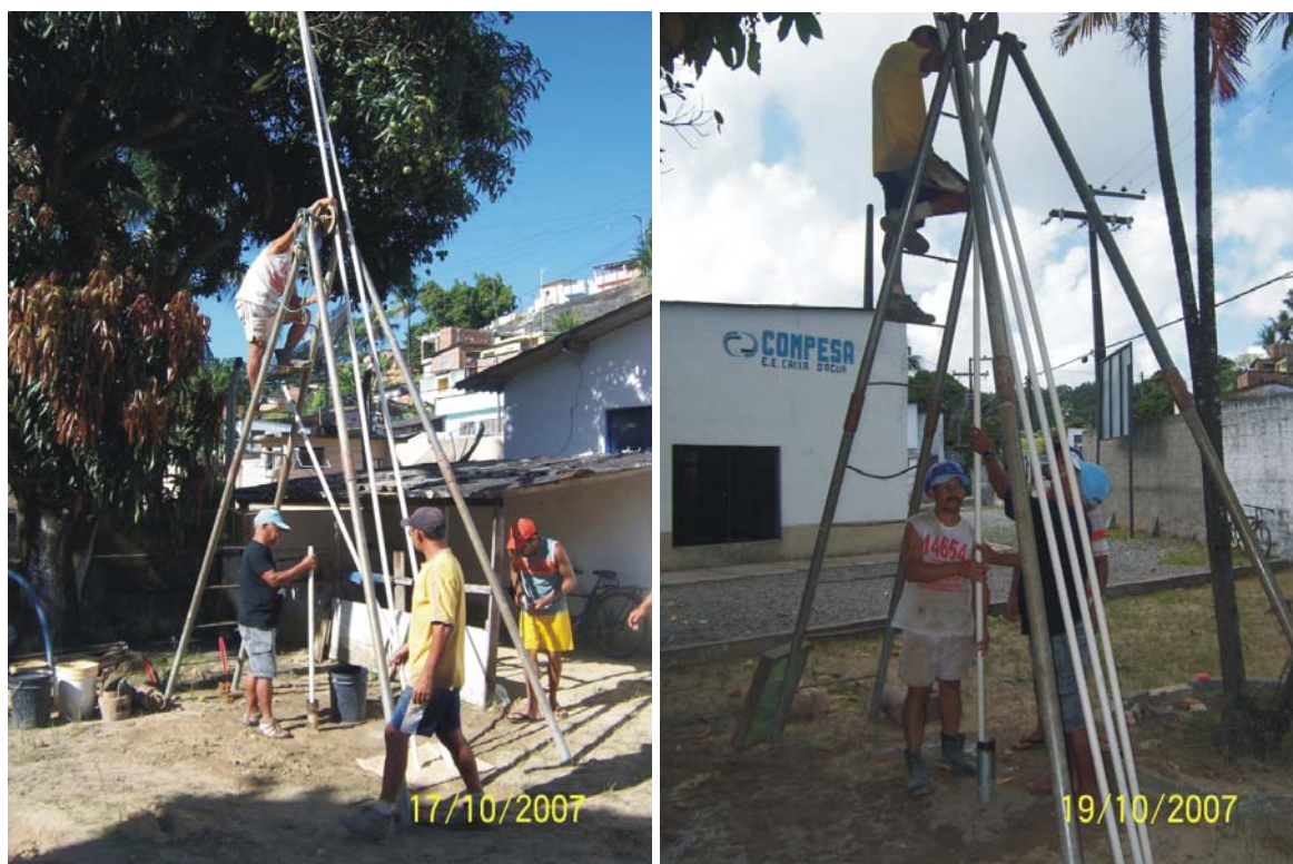
Figura 5.16 - Instalação dos poços de observação (piezômetros), SP4 e SP5.
