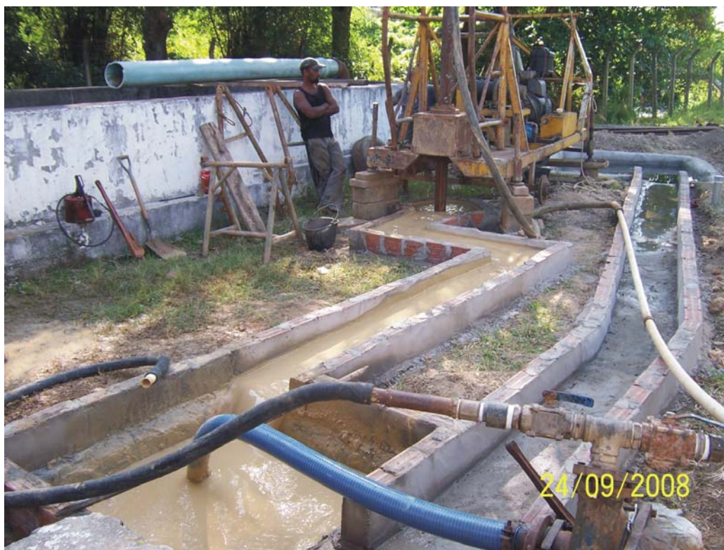
Figura 5.22 - Perfuração do poço de produção na EE Caixa d'Água.
