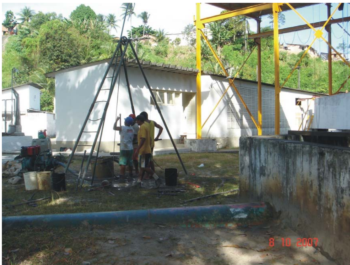
Figura 5.13 - Perfuração dos furos de sondagem, SP2.
