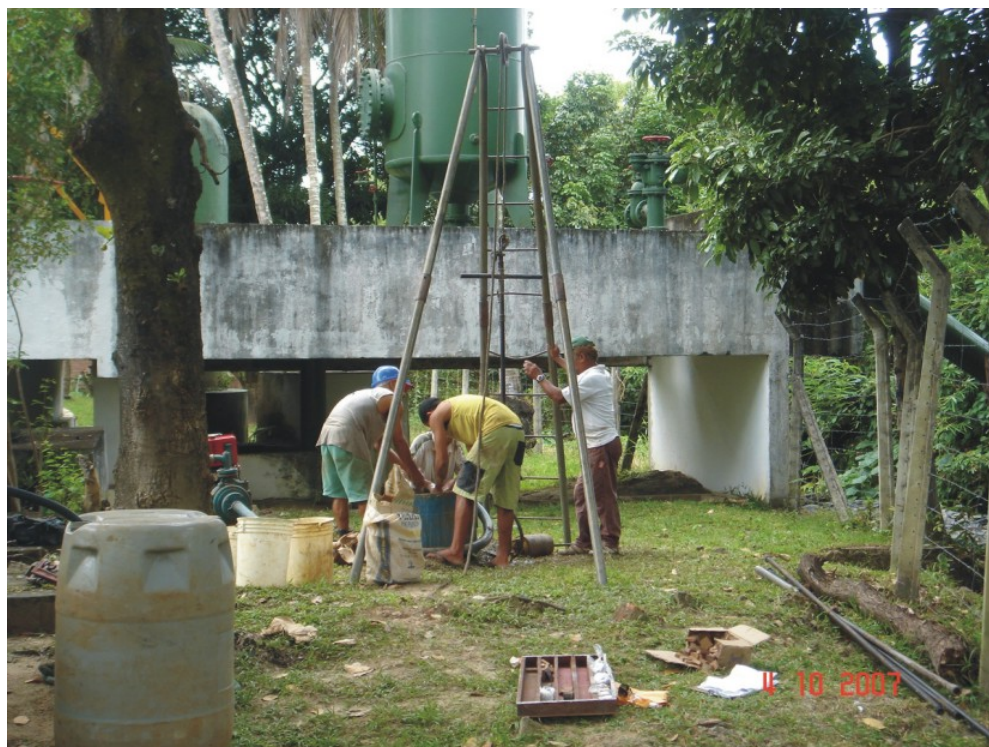
Figura 5.5 - Realização dos furos de sondagem, método de percussão (SPT).
