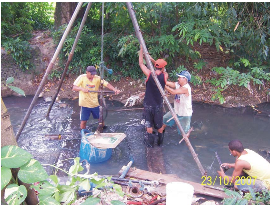
Figura 5.14 - Furo de sondagem no leito do rio, SP6.
