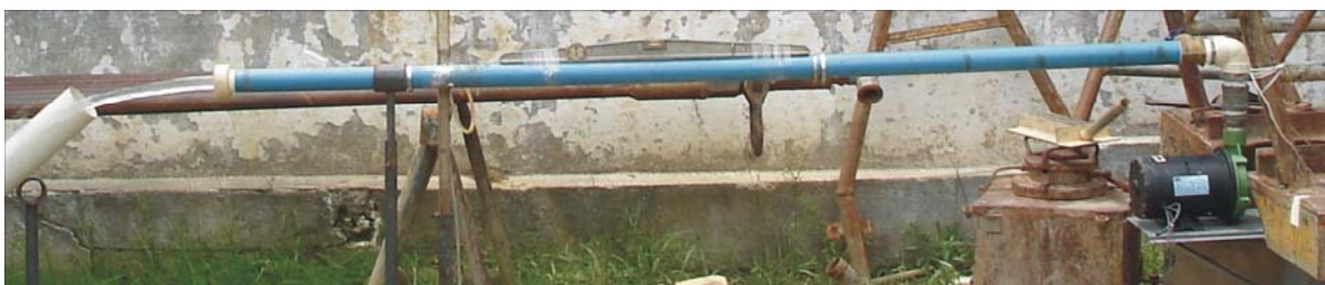
Figura 5.31 - Escoador de orifício circular utilizado no teste de bombeamento.
