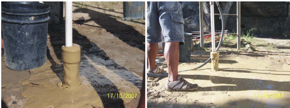
Figura 5.17 - Limpeza dos poços de observação, injeção de água por bomba.
