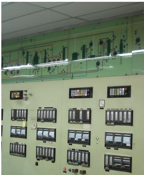
Figura 1.5: Ilustração de um antigo painel de controle de uma refinaria de petróleo. Na parte superior do painel é representado o fluxograma de engenharia da planta de processo. Na parte inferior estão presentes os controladores de processo, as chaves de configuração, as botoeiras e as indicações das variáveis do processo.
