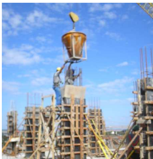
Figura 18 – Concretagem de pilares executada com o sistema de caçamba.
