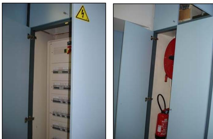
FIGURA 24 – Armário técnico para a distribuição de energia e para armazenar mangueiras de incêndio
