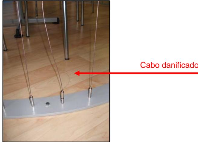
FIGURA 72 – Detalhe dos cabos da estrutura divisória
