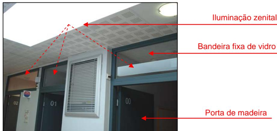
FIGURA 88 – Iluminação natural através das bandeiras fixas
