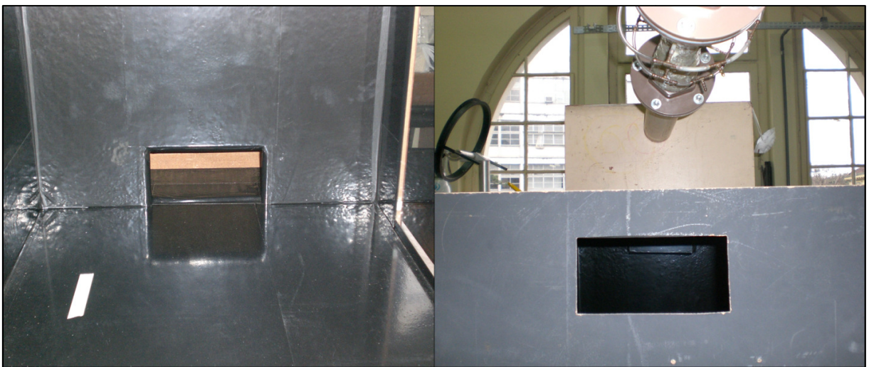
Figura 4.9 — Aberturas de insuflamento e exaustão
