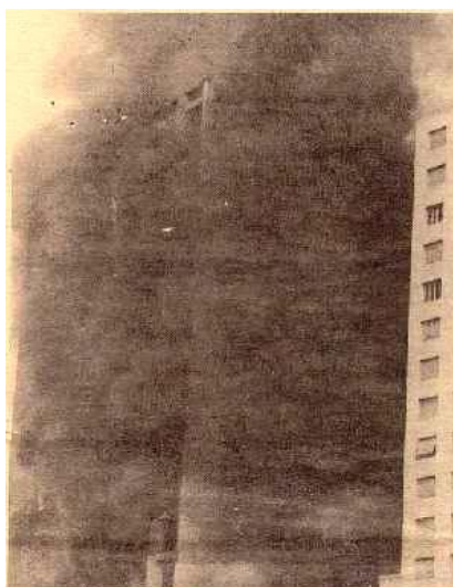
Figura 53 – A fumaça envolve todo o edifício Joelma. São Paulo, Brasil.
