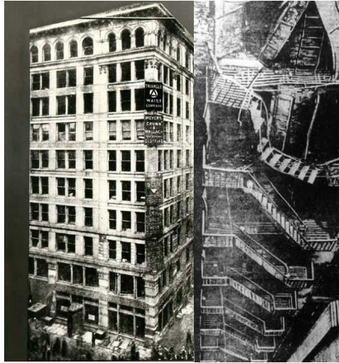
Figura 46 – Fachadas da fábrica de vestuário Triangle Shirtwaist Factory, em Nova York, EUA, e detalhe da escada da fábrica.
