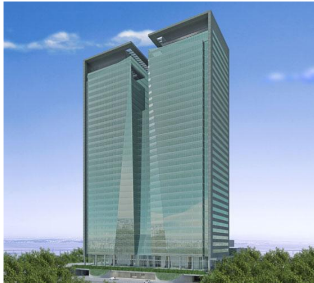
Figura 40 – Ventura Corporate Towers – Certificação LEED CS – Gold. Rio de Janeiro, Brasil.
