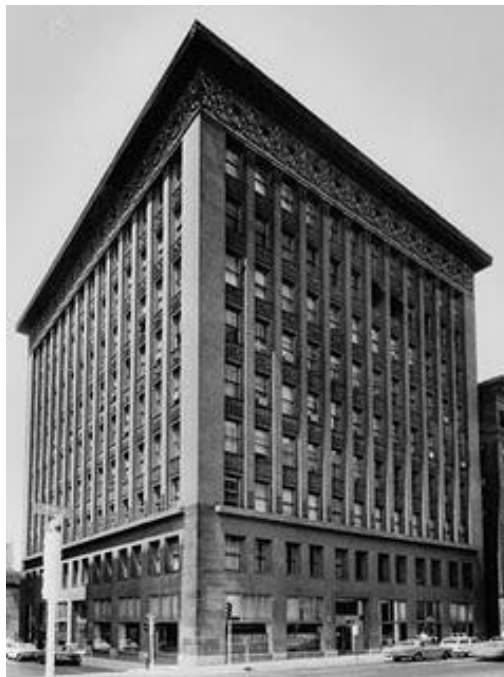
Figura 14 – Edifício Wainwright, de Louis Sullivan
