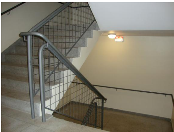
Figura 86 – Vista interna da escada de emergência.
