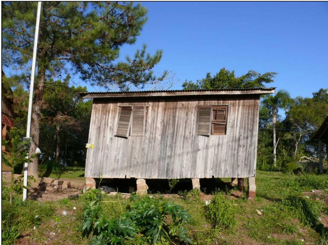
Figura 20: Residência Kaingáng da Lomba do Pinheiro, remanescente.
