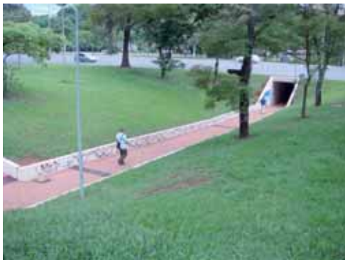
Figura 2.3 - Passagem de Pedestres sob o Eixo Rodoviário Sul
