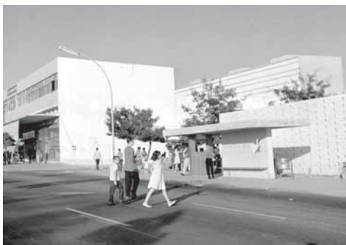
Figura 2.20 - Foto de 1964 - Abrigo em ponto de ônibus projeto Sabino Barroso, na avenida W3 Sul
