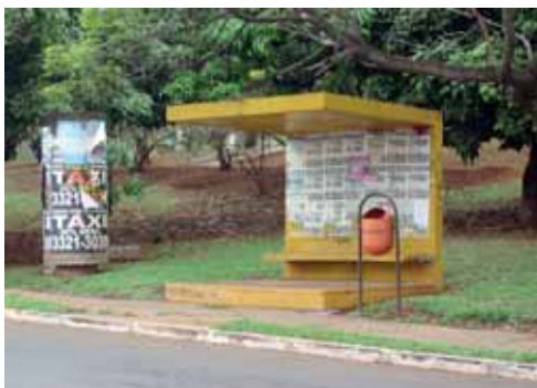
Figura 2.132 - Abrigo em ponto de ônibus dois módulos
