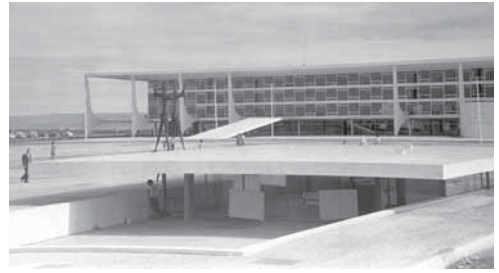
Figura 2.35 - Casa de Chá em 1967
