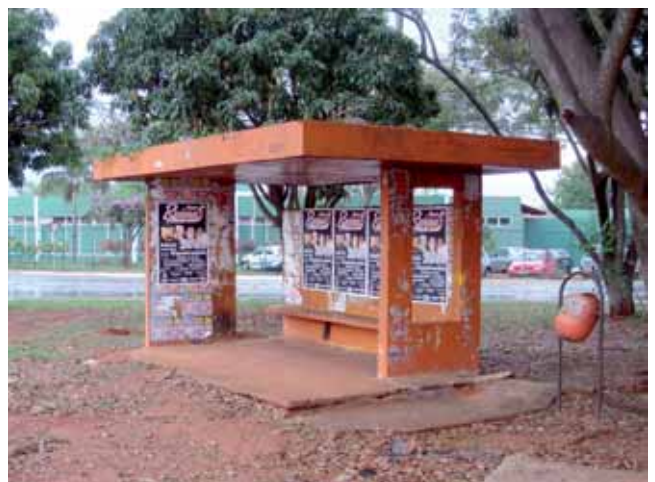
Figura 4.19 - Abrigo Secretaria de Viação e Obras
