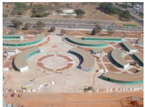
Figura 2.208 - Obras de urbanização do espaço destinado a Feira da Torre de TV
