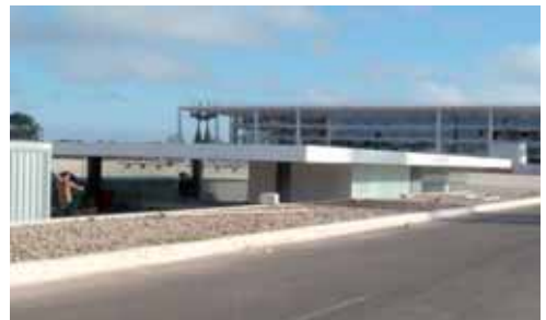
Figura 2.36 - Casa de Chá em reforma - 2010
