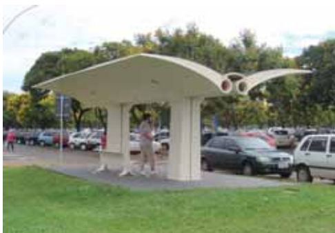
Figura 2.147 - Abrigo em ponto de ônibus
