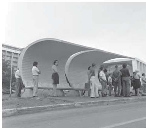
Figura 2.75 - Abrigo em ponto de ônibus projetado por Donar Techmeier - Localizado no Eixo Monumental - Foto de 1976
