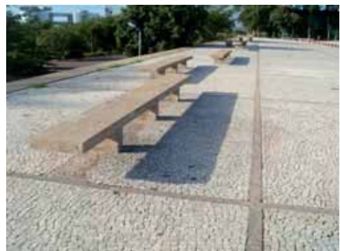
Figura 2.32 - Bancos de concreto na Praça dos Três Poderes
