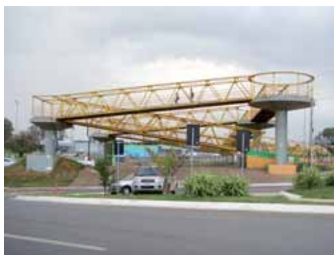
Figura 2.171 - Passarela de pedestre sem cobertura na EPIA - Região da Candangolândia
