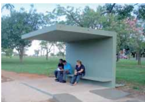
Figura 2.133 - Abrigo em ponto de ônibus com três módulos
