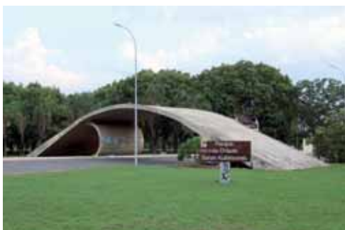
Figura 2.106 - Portal de acesso ao parque
