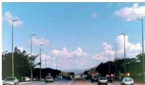
Figura 2.143 - Postes e Luminárias do Eixo Rodoviário
