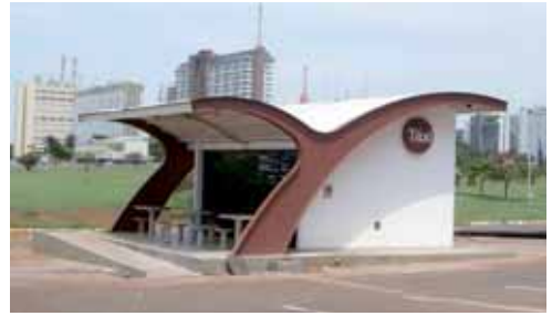
Figura 2.193 - Abrigo em ponto de Taxi
