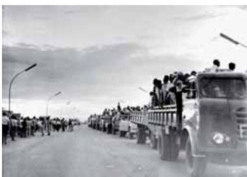
Figura 2.9 - Luminárias no Eixo Rodoviário na inauguração da cidade
