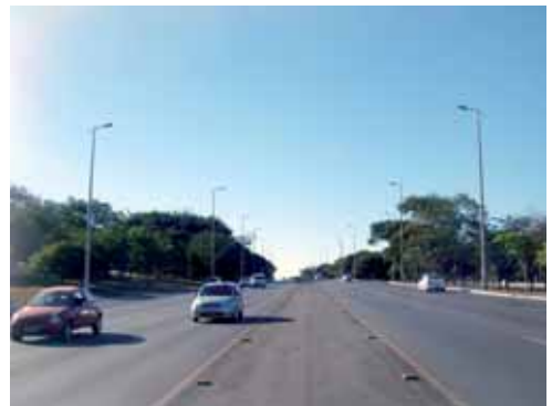
Figura 2.186 - Luminárias no Eixo Rodoviário
