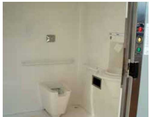
Figura 2.206 - Sanitário Público - interior
