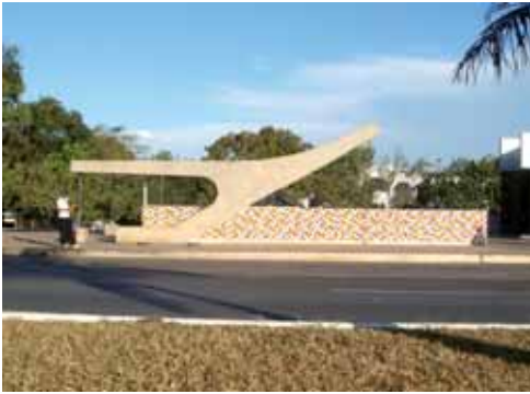
Figura 2.189 - Acesso à Estação de Metrô 108 Sul
