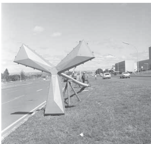
Figura 2.98 - Instalação de luminárias na via L2 Sul
