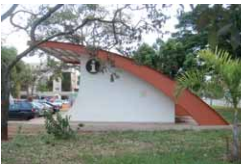
Figura 2.192 - Centro de Atendimento ao Turista no Setor Hoteleiro Sul
