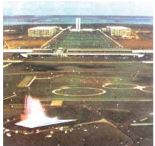
Figura 2.42 - Esplanada da Torre de TV, antes da construção do viaduto na avenida W3, com a fonte luminosa em funcionamento.
