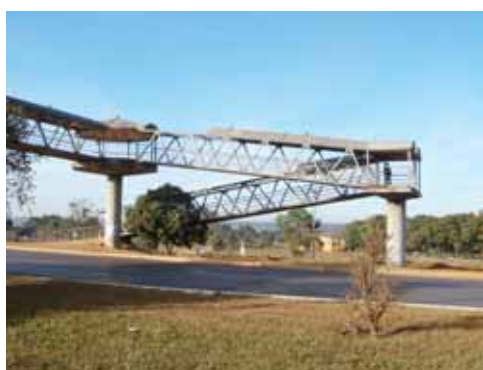
Figura 2.176 - Passarela elevada de pedestres do Zoológico
