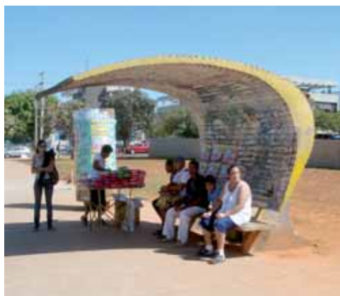
Figura 2.77 - Abrigo projetado por Donar Techmeier na via EPIG em 2010
