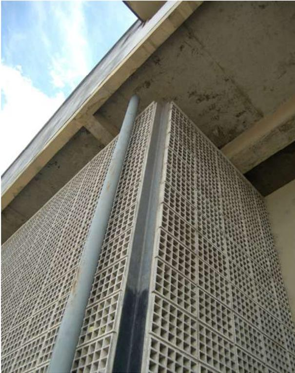
Figura 82: conexão entre a verga da vitrine e os planos de elementos vazados com aresta em cantoneira metálica.
