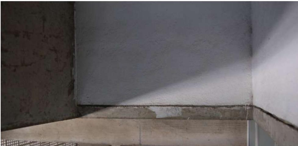
Figura 82: as juntas entre os diferentes materiais; concreto e alvenaria com reboco
