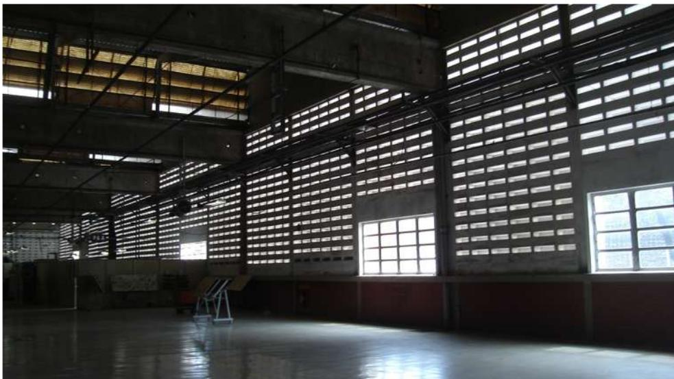
Figura 54: elementos vazados em todo o perímetro do bloco de produção
