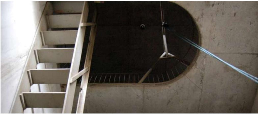
Figura 84: Abertura na laje do 1º piso para a instalação do elevador monta-carga, eixo de conexão.
