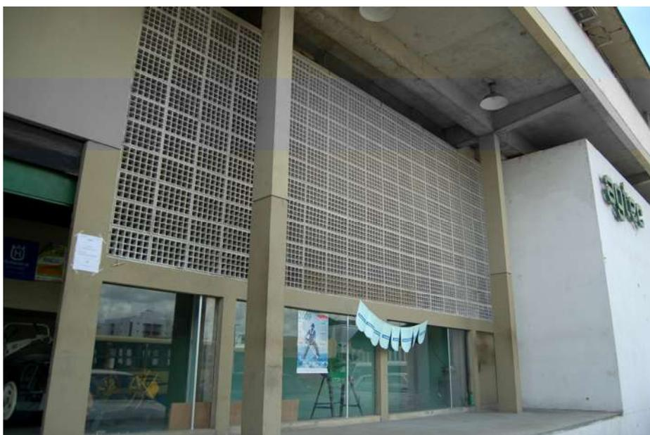
Figura 71: Nesta imagem pode-se observar o recuo de parte da fachada, que por sua vez é composta de elementos vazados e não toca na laje, atendendo assim a três recomendações simultaneamente.
