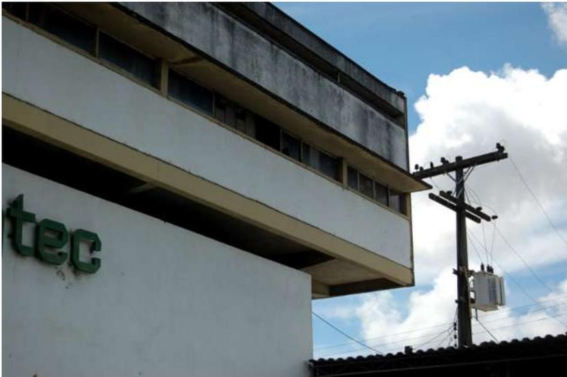
Figura 73: a proteção da janela voltada para poente (recomendação 5 do Roteiro), com abas em concreto.
