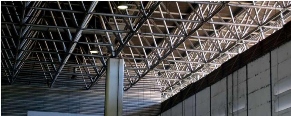
Figura 108: o encontro do fuste da coluna com o nó principal da estrutura da cobertura
