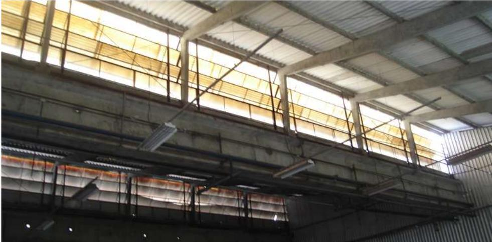
Figura 55: aberturas na cobertura para facilitar a circulação do ar
