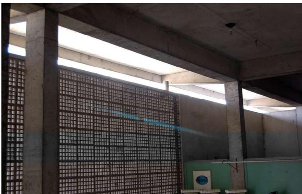
Figura 72: os recursos de não encontrar a vedação e a laje (recomendação 7) e o uso de elementos vazados (recomendação 4 do Roteiro) vistos do interior do edifício.
