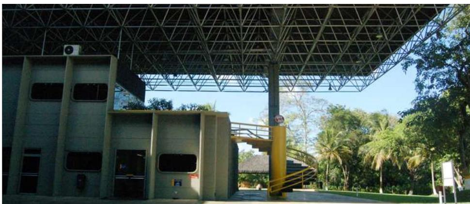
Figura 107: trecho da cobertura que liga dois blocos e marca o seu acesso, funcionando como um pórtico
