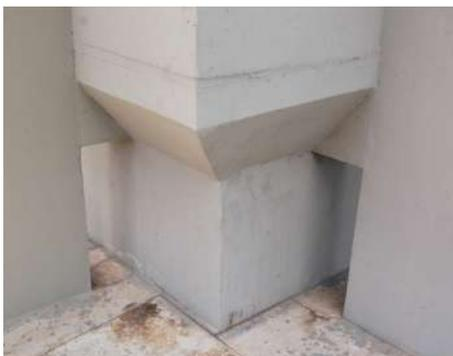
Figura 109: articulação entre a base da construção, as placas e os montantes da vedação na aresta dos planos das fachadas.
