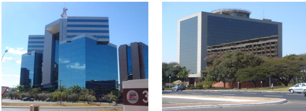
Figura 2.12 – Edifício Corporate Financial Center e Ministério Público do Distrito Federal e Territórios, respectivamente 16
