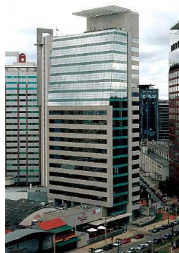
Figura 2.9 – Edifício Boulevard Sul 12
