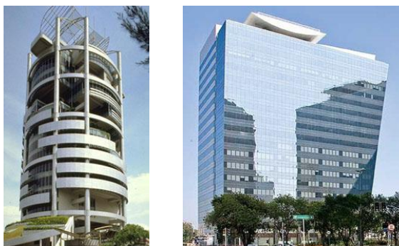
Figura 7.39 – Edifícios indicados nas questões 14 e 15 - Menara Mesiniaga e Rochaverá, respectivamente
