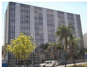
Figura 7.35 – Edifício pior classificado na apreciação do tipo de vidro
