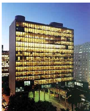
Figura 2.7 – Edifício do Ministério da Educação e Saúde - MEC 10
