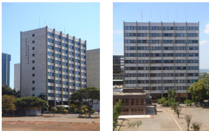
Figura 5.12 – Edifício Justiça Federal Sede I
