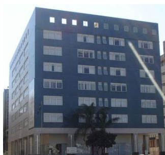
Figura 7.33 – Edifício pior classificado na apreciação da fachada
