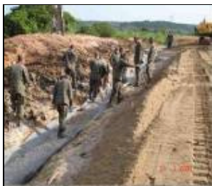
d) execução do dreno de alívio
