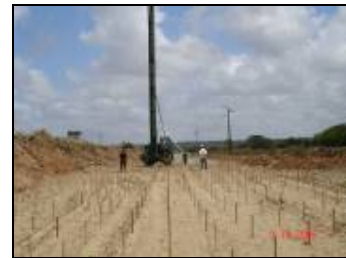
c) instalação do geodreno
