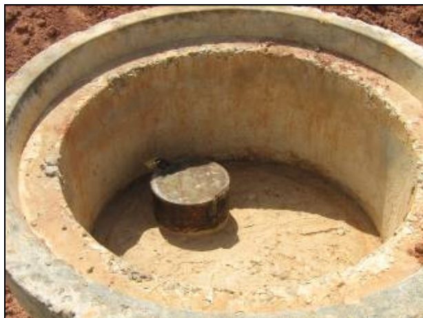
FIGURA 8 – FOTO DA PROTEÇÃO METÁLICA DO INCLINÔMETRO, RODOVIA BR-101, SETEMBRO 2007
