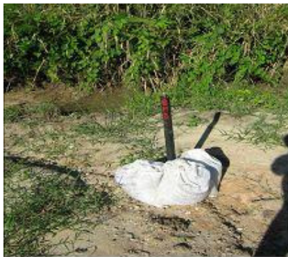
Foto 7 – Vista do Bench Mark instalado
