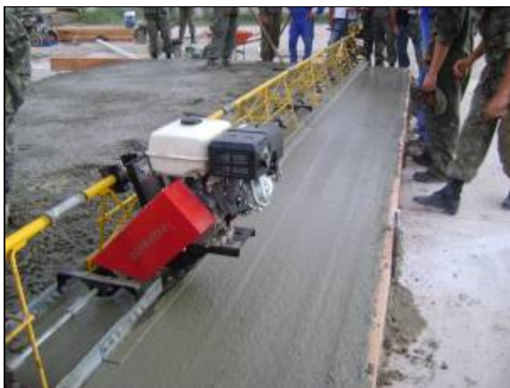
FIGURA 4 – EXEMPLO DE EQUIPAMENTO DE PEQUENO PORTE FOTO: FRANCELINO, M.J.M Régua Treliçada Vibratória . 2008. 1 foto digital
