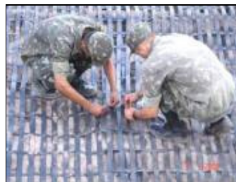
e) instalação da geogrelha
