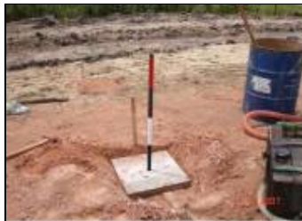
h) instalação da placa de recalque
