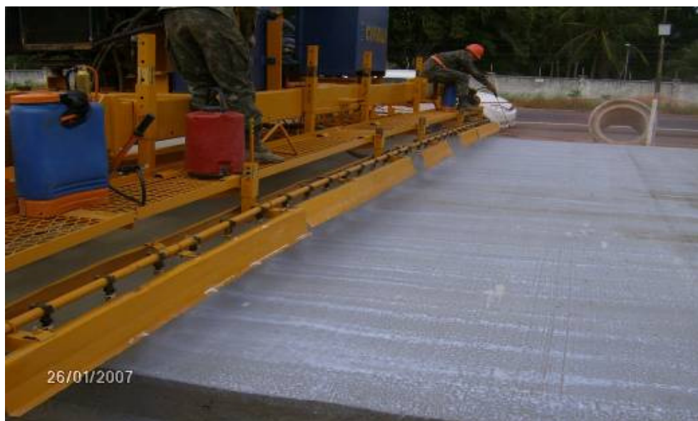
FIGURA 6 – EXEMPLO DE TEXTURIZADORA E APLICADORA DE PRODUTO DE CURA FOTO: FRANCELINO, M,J,M. Terex CMI – TC 2604 , 2002. 1 fot.: color.; 10 x 15cm.
