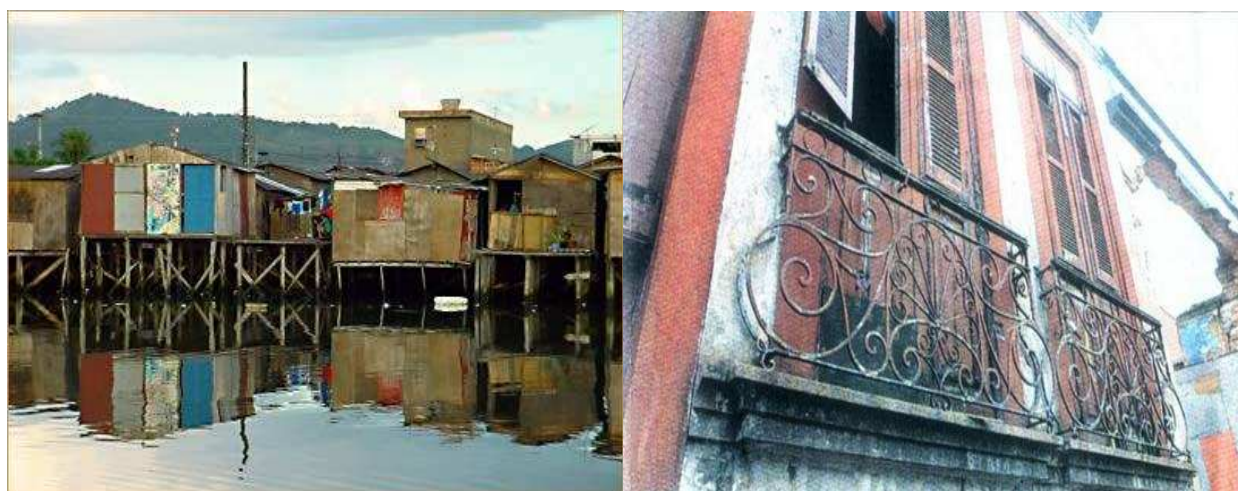
Fotos 3.23 e 3.24 - Palafitas na Favela do Dique e a deterioração dos Cortiços na área central de Santos. Foto 23: Carlos Nogueira, publicada em A Tribuna , em matéria do dia 08/02/2004. Fonte: site Viva Santos (2008).
