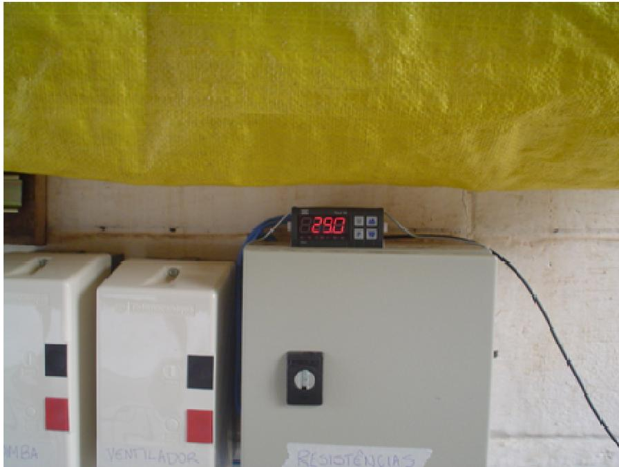
*Figura 2.5-7: Termostato para acionamento de TAE, indicando temperatura no interior da sala.*
