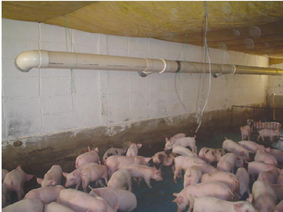
***Figura 2.5-4: Tubulação de distribuição do ar quente do interior da sala.***
