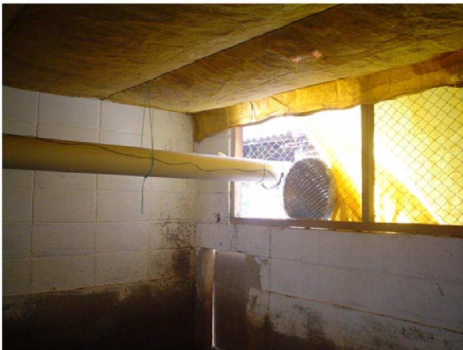
***Figura 2.5-5: Tubulação de captação do ar quente no interior da sala.***
