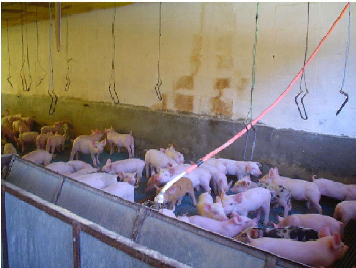
*Figura 2.5-1: Sistema de aquecimento por resistências elétricas suspensas, instalado na baia.*
