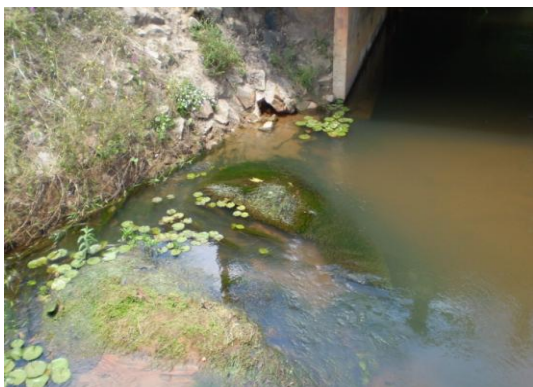
Figura 4.5- Ponto PIR 5, Ponte Trampolim da Vitória, no Município de Parnamirim
