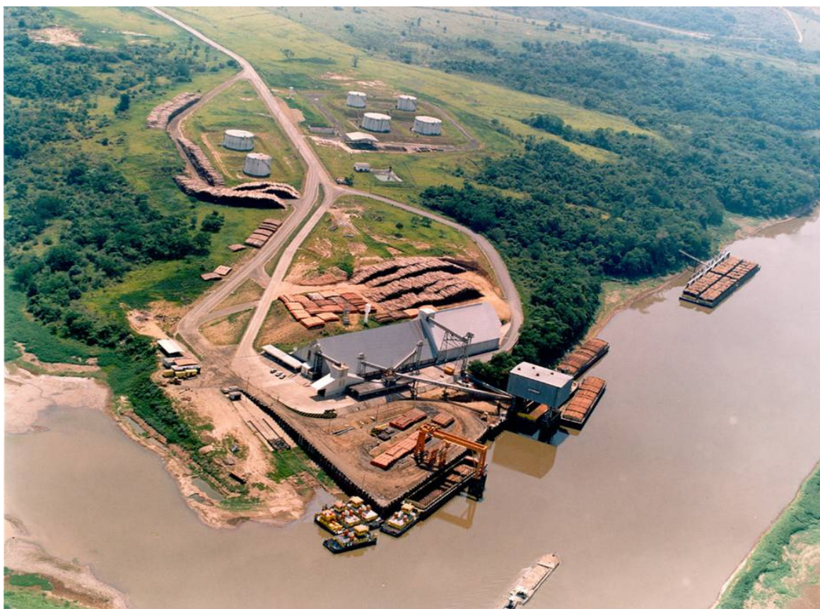
Figura 28 - Terminal hidroviário de etanol em Anhembí
