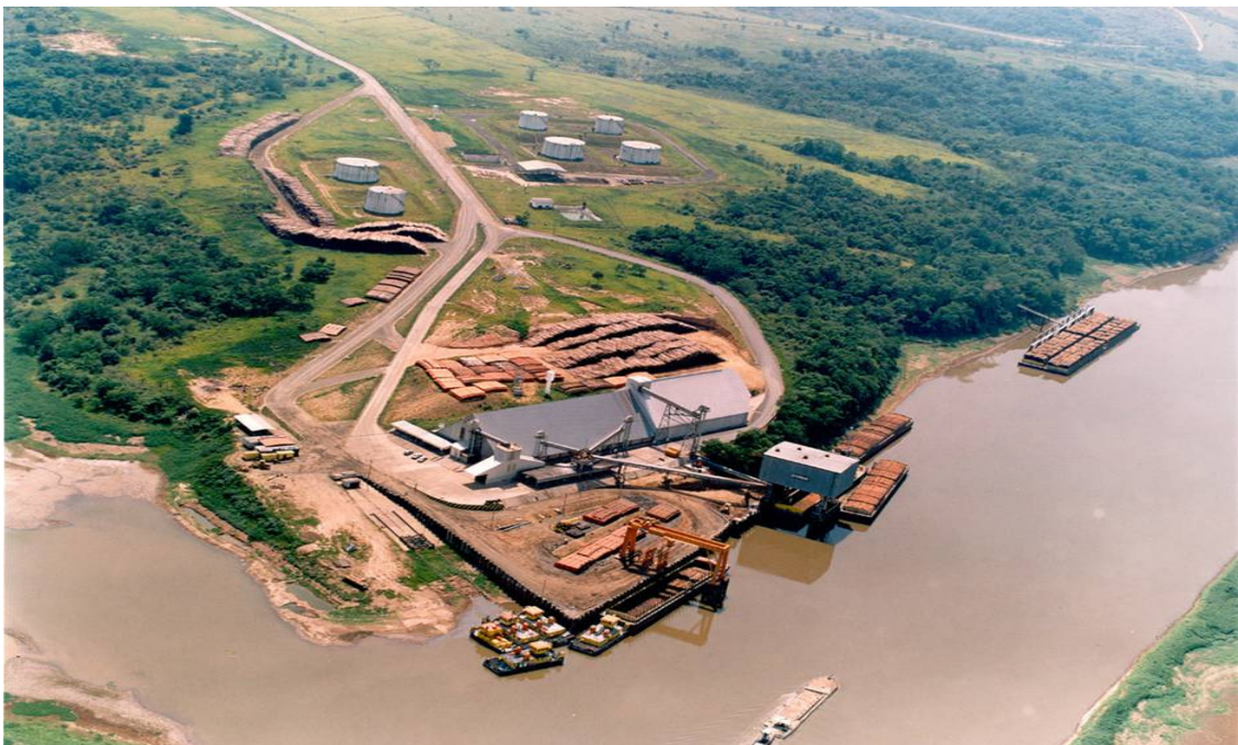
Figura 21 - Terminal de transbordo hidroviário em Anhembi Fonte: DNP.
