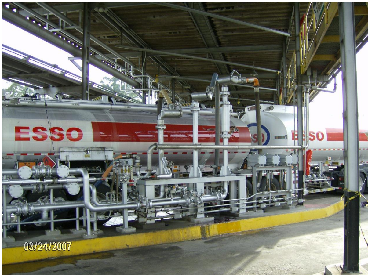
Figura 5.2 – Ilha de carregamento através do método bottom
