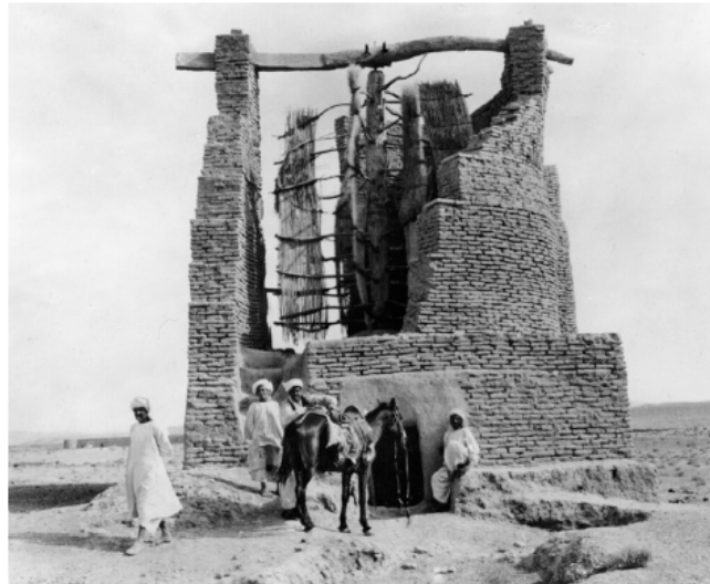
Figura 2.1 – Moinho de Vento vertical para moagem de grãos no Afeganistão [Hau, 2006]
