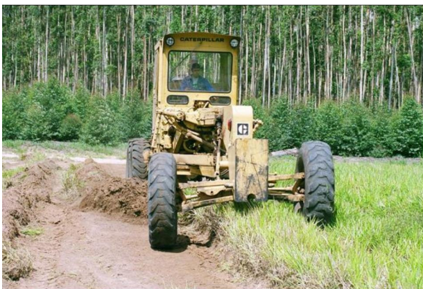
FIGURA 12. Raspagem do solo para retirada da braquiária
