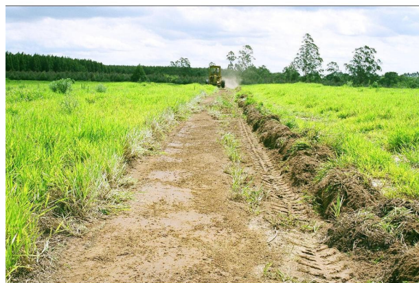
FIGURA 13. Detalhe da raspagem da área.
