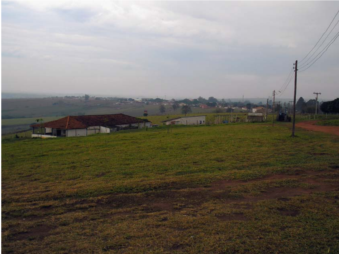
Figura 25 - À esquerda, o galpão onde são realizados os bailes (Foto: Mário M. Sakaguti Jr., 2009)
