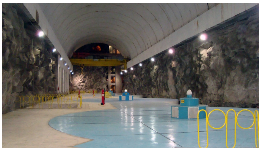
Figura 1.4 – Topo do gerador das unidades geradoras (03G1, 03G2, 03G3 e 03G4) da usina PA III.
