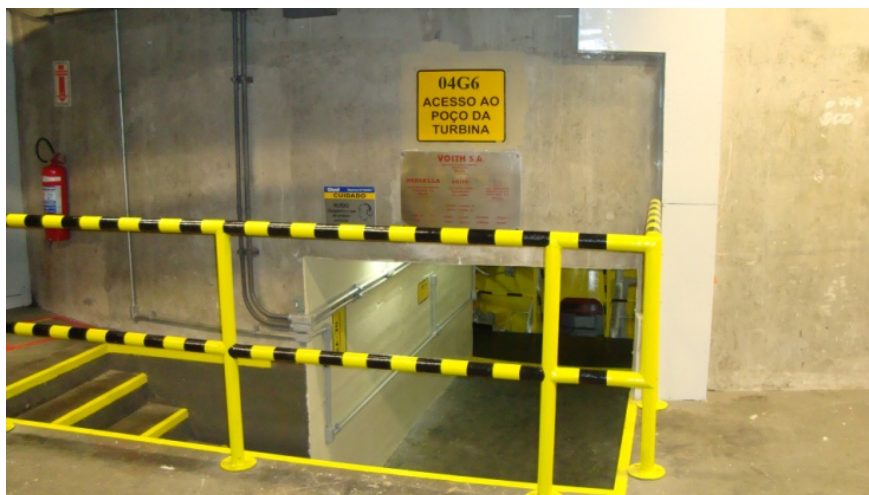
Figura 4.24 – Corredor de acesso ao poço da turbina da unidade geradora 04G1.
