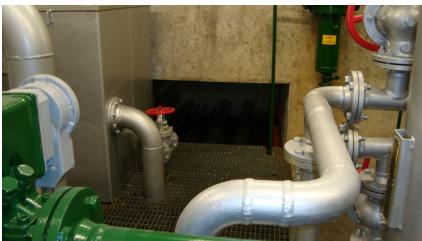
Figura 4.25 – Abertura oposta ao corredor de acesso ao poço da turbina da unidade geradora 04G1.
