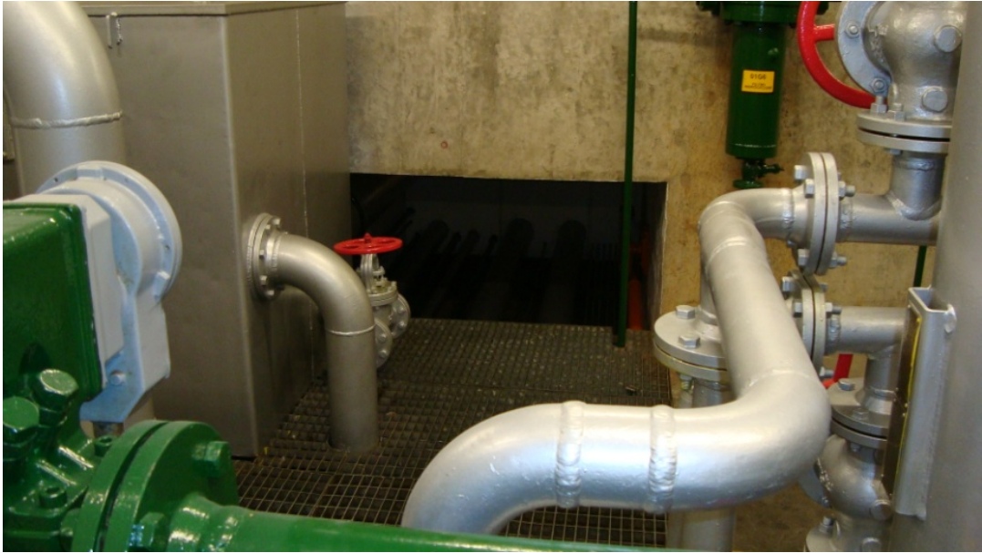
Figura 6.25 – Área dos dutos de transporte de óleo dos mancais: área de saída de energia sonora com nível intenso.
