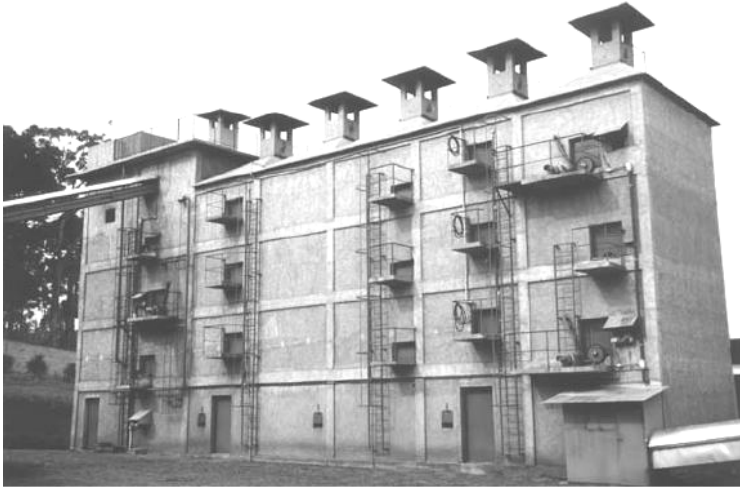
Figura 1.13 Estrutura do secador de erva-mate em esteira Fonte: Maccari Junior (2005)
