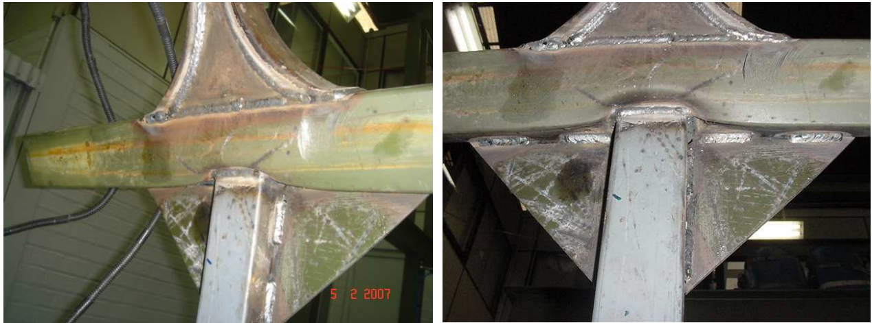
Figura 5.4: Detalhe da rótula plástica formada no corpo de provas ULB2F após o ensaio.
