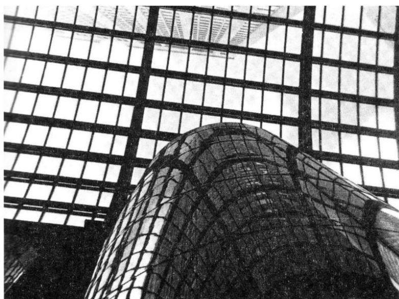
FIGURA 1.3 - Detalhe da passagem monumental do primeiro nível do edifício AT&T. Fotografia de Daniele Moretti.
