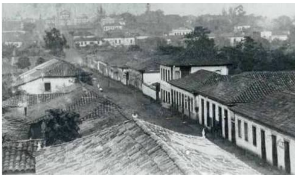
Figura 2 - Rua Artur Machado, na área central de Uberaba, evidencia o caráter semirrural da cidade em 1885
