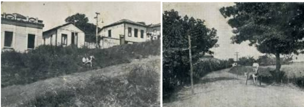
Imagens de logradouros da área central de Uberaba, no final da década de 1920, demonstram a simplicidade colonial e o aspecto rural do restante da cidade. Na Figura 6 (esq.), detalhe para o mato invadindo a pista de terra da ladeira do Rosário, no centro da cidade. Na figura 7 (dir.), rua do Cotovelo, também no centro. Ao fundo, o Mercado Municipal.
