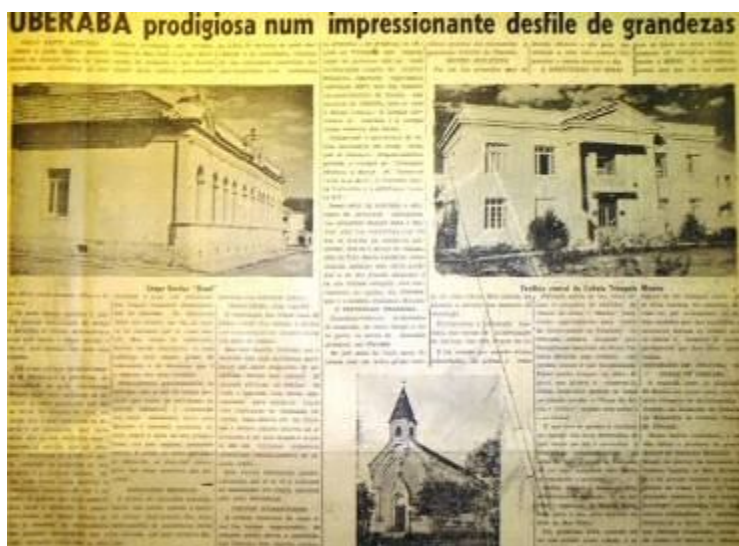
Figura 64 – Pavilhão central do Colégio Triângulo Mineiro simbolizava um dos mais importantes exemplos do patrimônio material de Uberaba nos anos 1940
